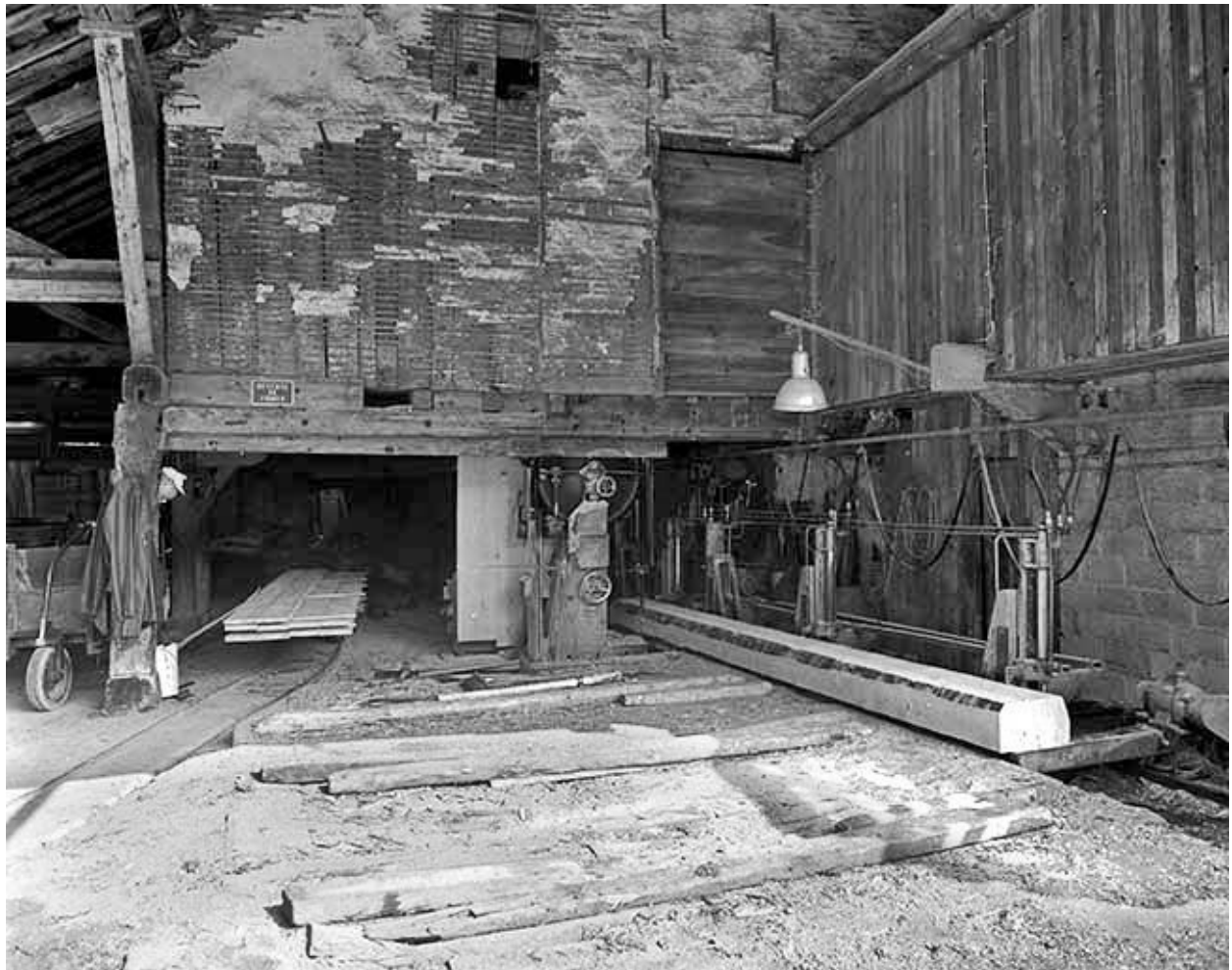
Intérieur de l'atelier de sciage.
