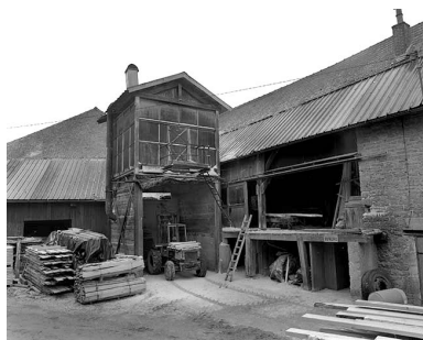
Silo à sciure et atelier de fabrication.
