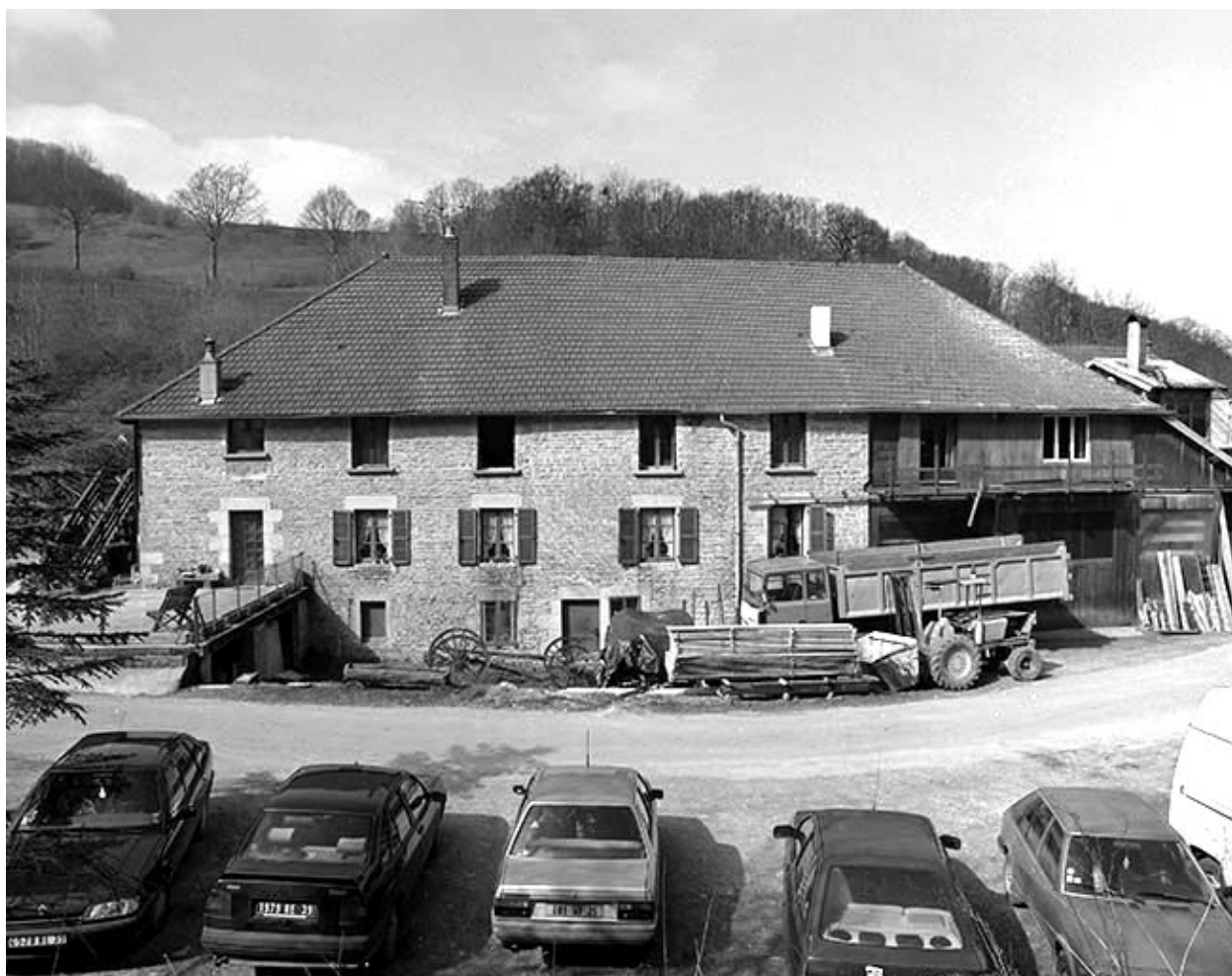
Logement et atelier de fabrication : façade antérieure.
