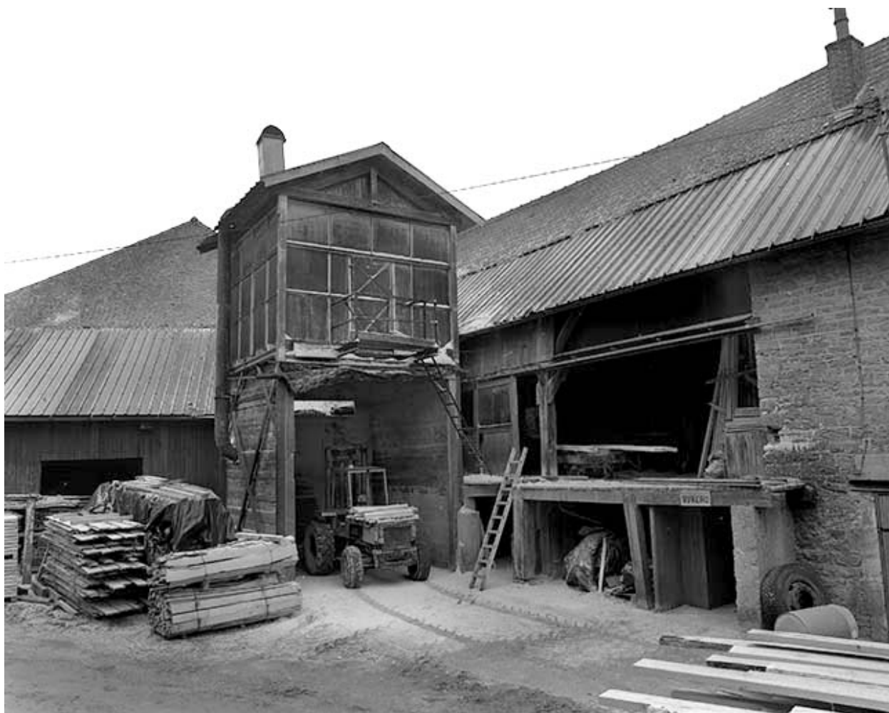
Silo à sciure et atelier de fabrication.
