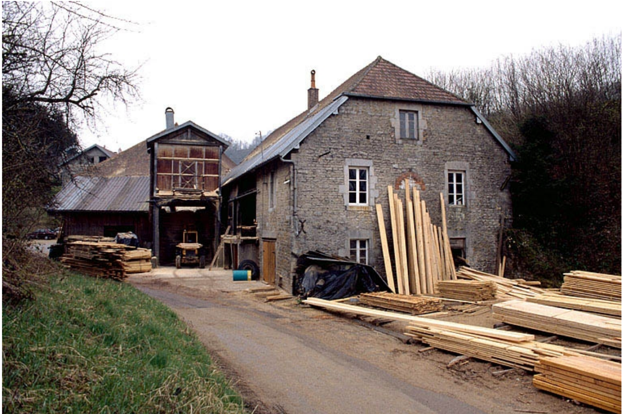
Atelier de fabrication nord.
