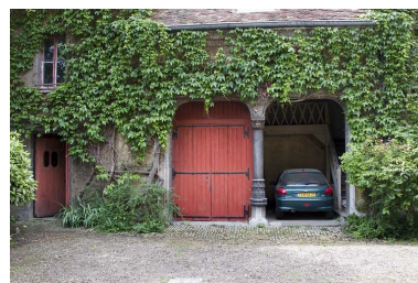
Bâtiment des remises : façade antérieure.
