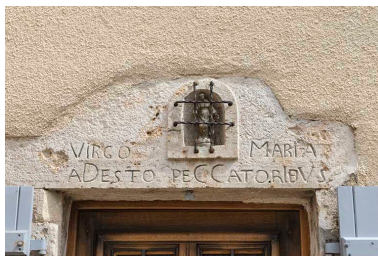
Date portée inscrite sur le linteau de la porte d'entrée. Phot. Jérôme Mongreville IVR43_20187000188NUC4A
