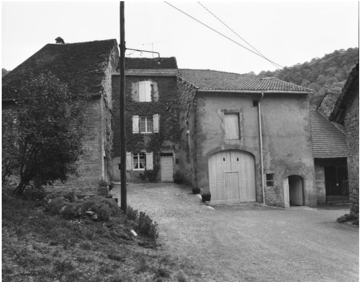
Vue générale de la façade antérieure.
