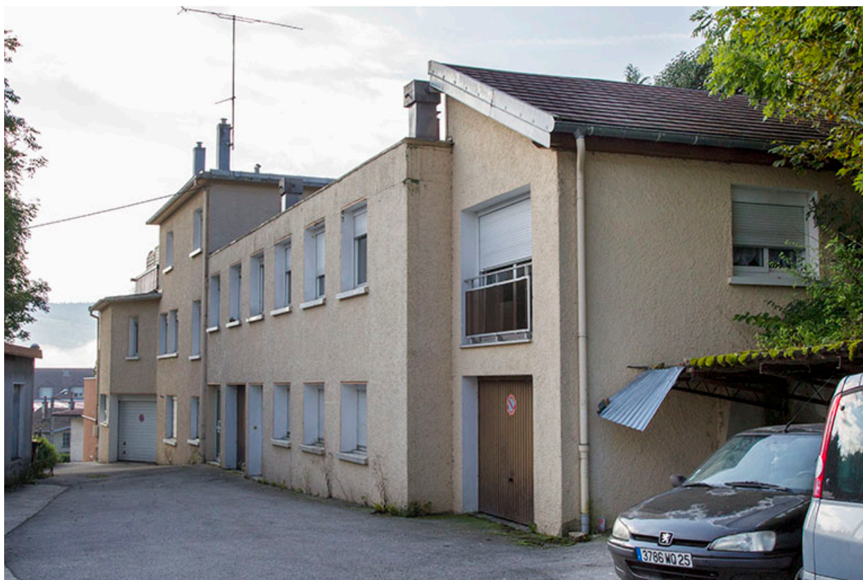
Façade latérale droite, depuis le nord.
