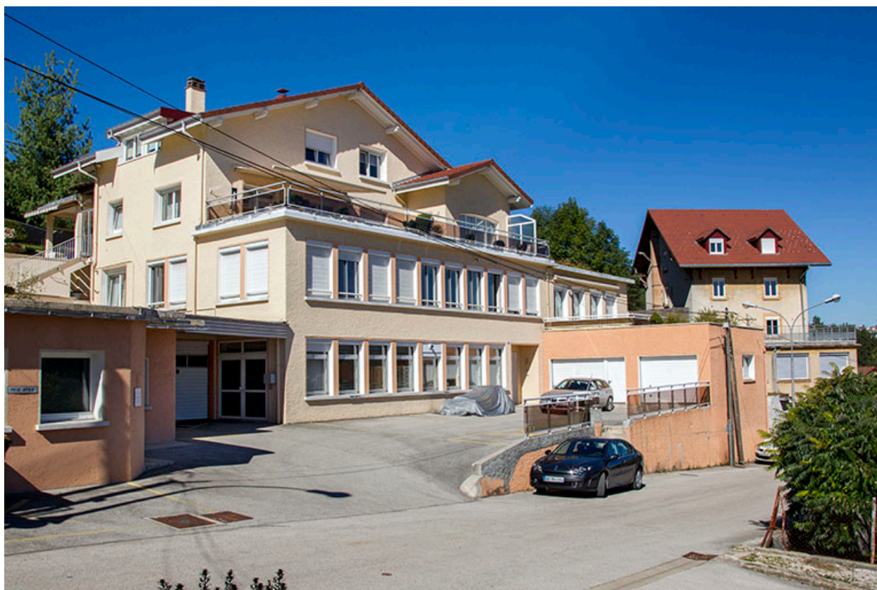
Façades antérieure et latérale gauche.
