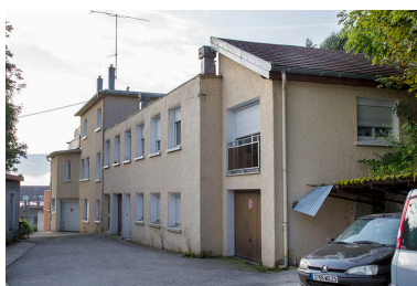
Façade latérale droite, depuis le nord. Phot. Yves Sancey IVR43_20132502395NUC2A
