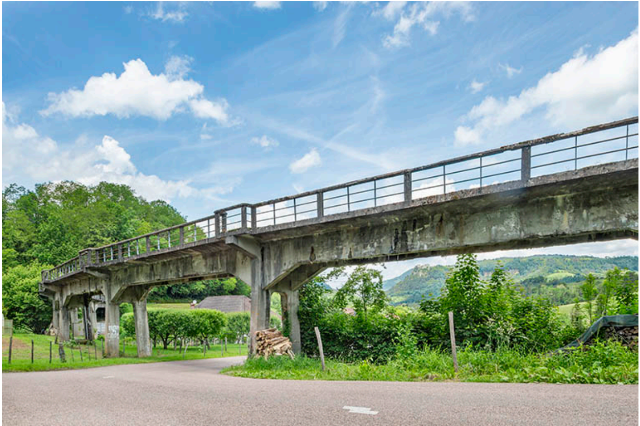
Vue d'ensemble depuis la route de Chaux-Champagny.
