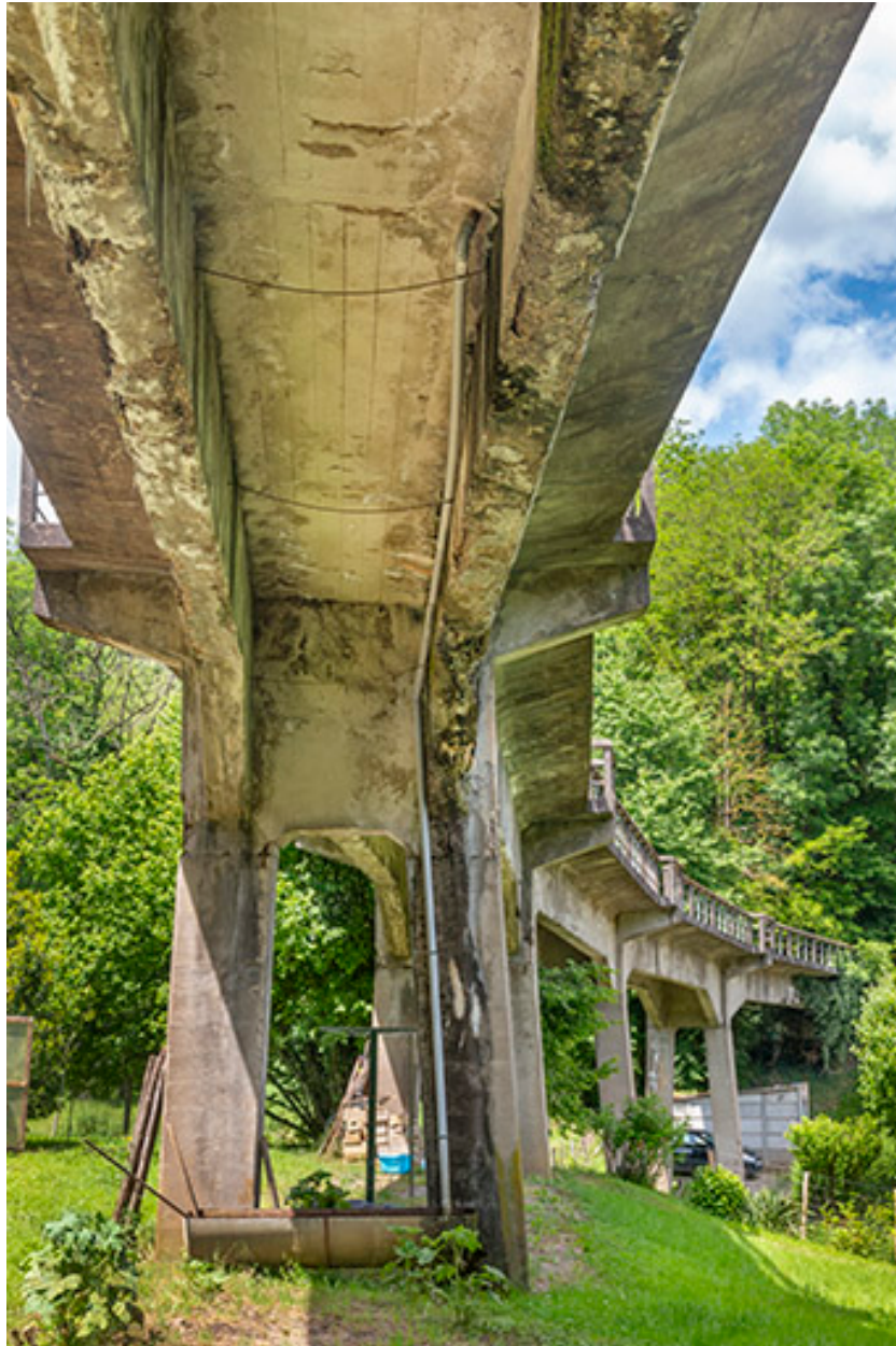
Vue prise sous le pont, depuis la route de Chaux-Champagny.
