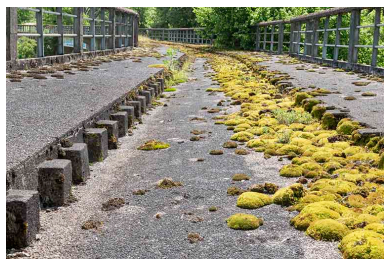
Détail de la chaussée. Phot. Jérôme Mongreville IVR43_20243900783NUC4A
