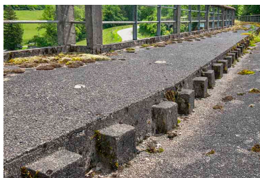
Détail du trottoir et de la chaussée. Phot. Jérôme Mongreville IVR43_20243900784NUC4A
