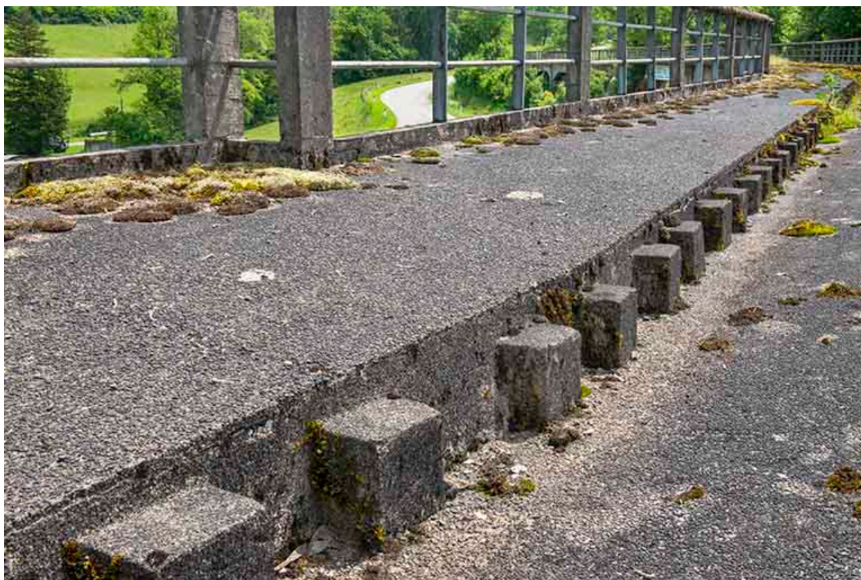
Détail du trottoir et de la chaussée.
