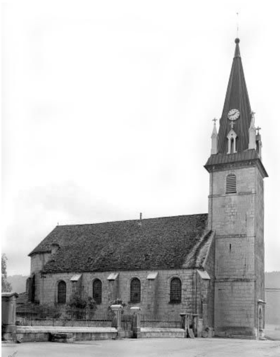
Façade laérale gauche.
