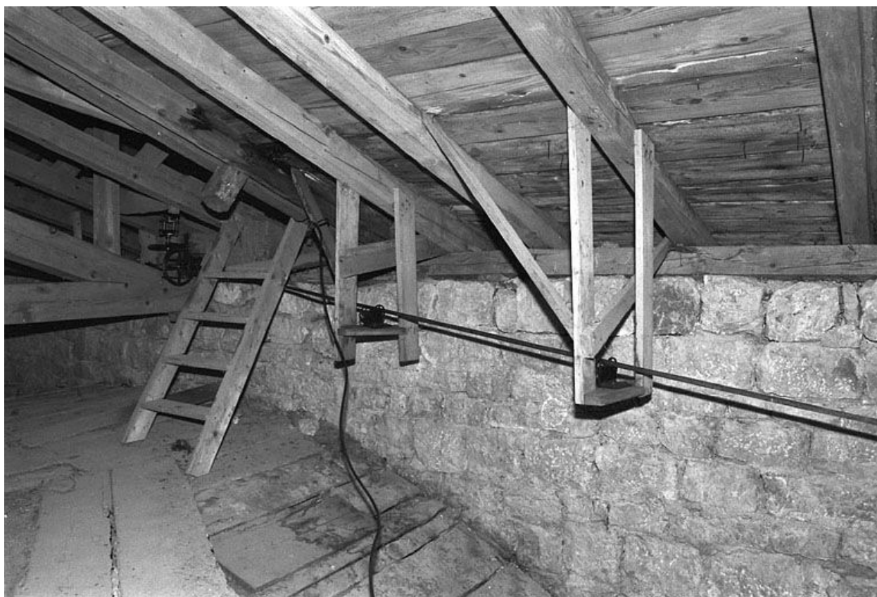
Tige de transmission du mouvement aux aiguilles du cadran extérieur sud.
