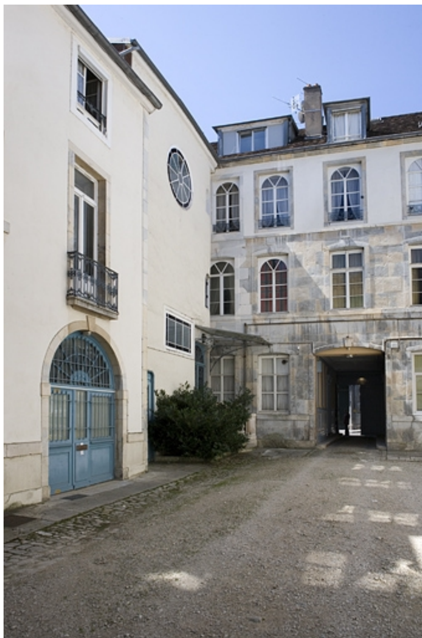
Vue de la façade postérieure du logis principal et de l'aile à droite de la cour.
