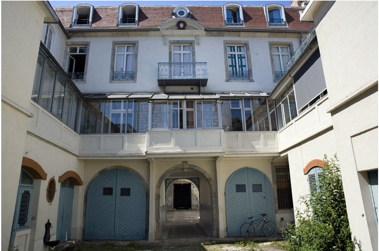
Façade postérieure du logis secondaire, de face.
