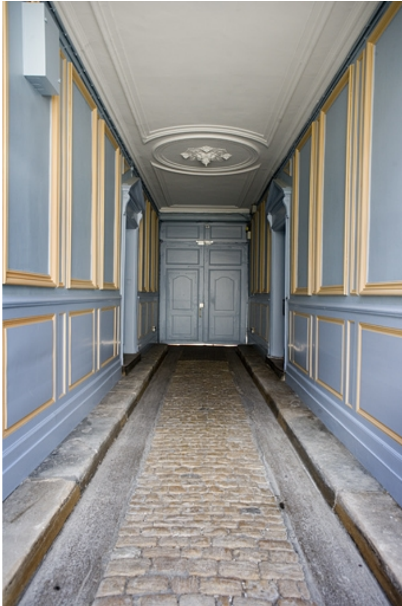
Logis principal : vue rapprochée du passage cocher depuis la cour.
