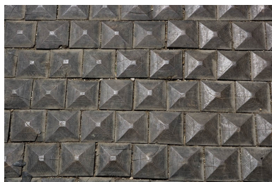
Logis principal : détail des pavés en bois du passage cocher. Phot. Yves Sancey IVR43_20082500464NUC2A
