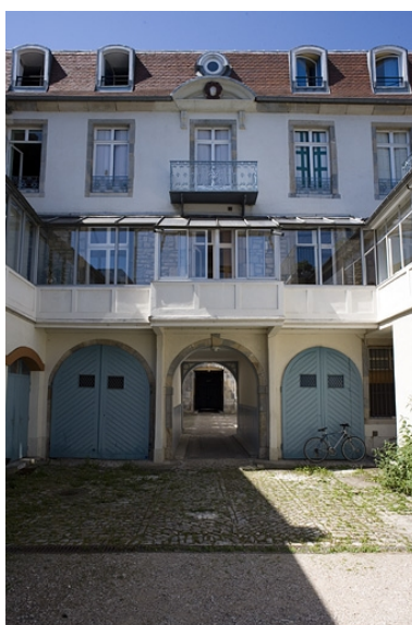
Vue de la partie centrale de la façade postérieure du logis secondaire, de face.
