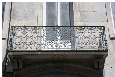
Logis principal : détail du balcon au-dessus du portail d'entrée.
