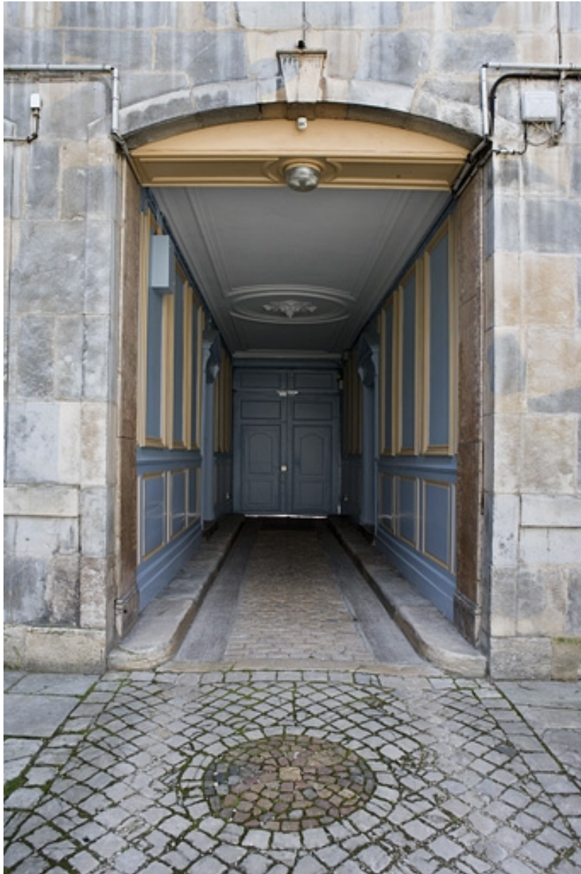
Logis principal : vue d'ensemble du passage cocher depuis la cour.
