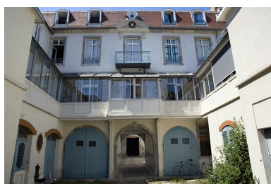
Façade postérieure du logis secondaire, de face.
