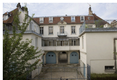
Logis secondaire : vue d'ensemble des bâtiments autour de la deuxième cour. Phot. Yves Sancey IVR43_20082500459NUC2A
