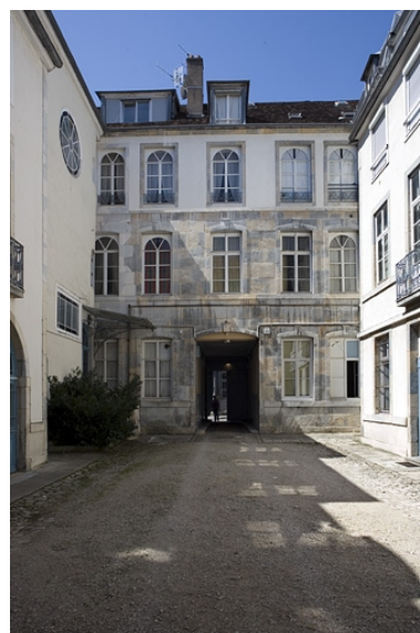
Vue d'ensemble des bâtiments autour de la première cour.
