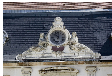
Détail de l'horloge couronnant la partie centrale du logis au fond de la première cour : vue rapprochée. Phot. Yves Sancey IVR43_20082500449NUC2A
