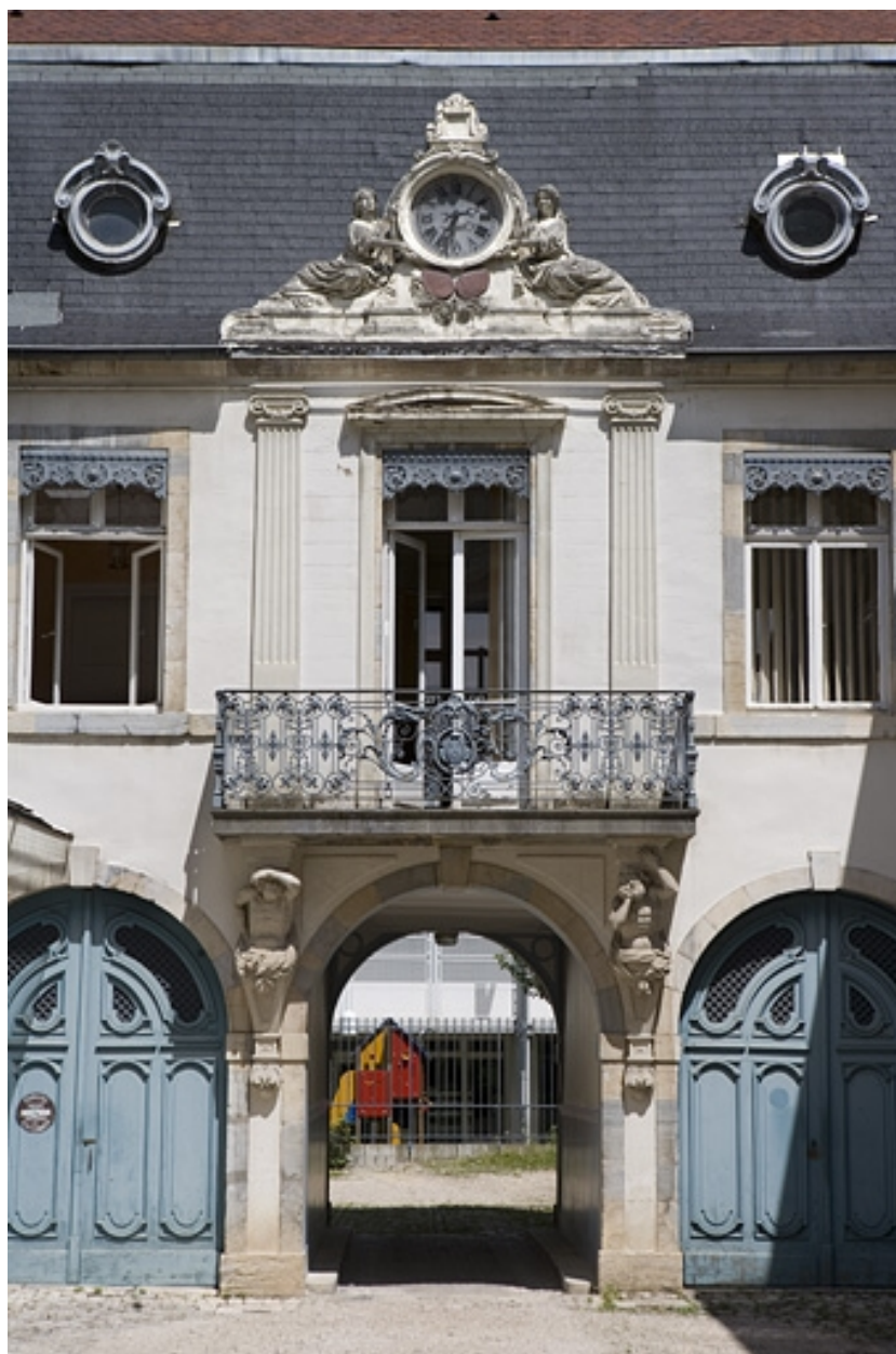
Détail de la partie centrale du logis au fond de la première cour.
