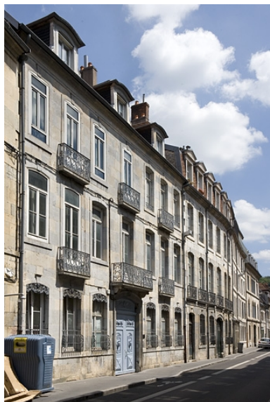
Vue d'ensemble dans l'alignement de la rue, de trois quarts gauche.
