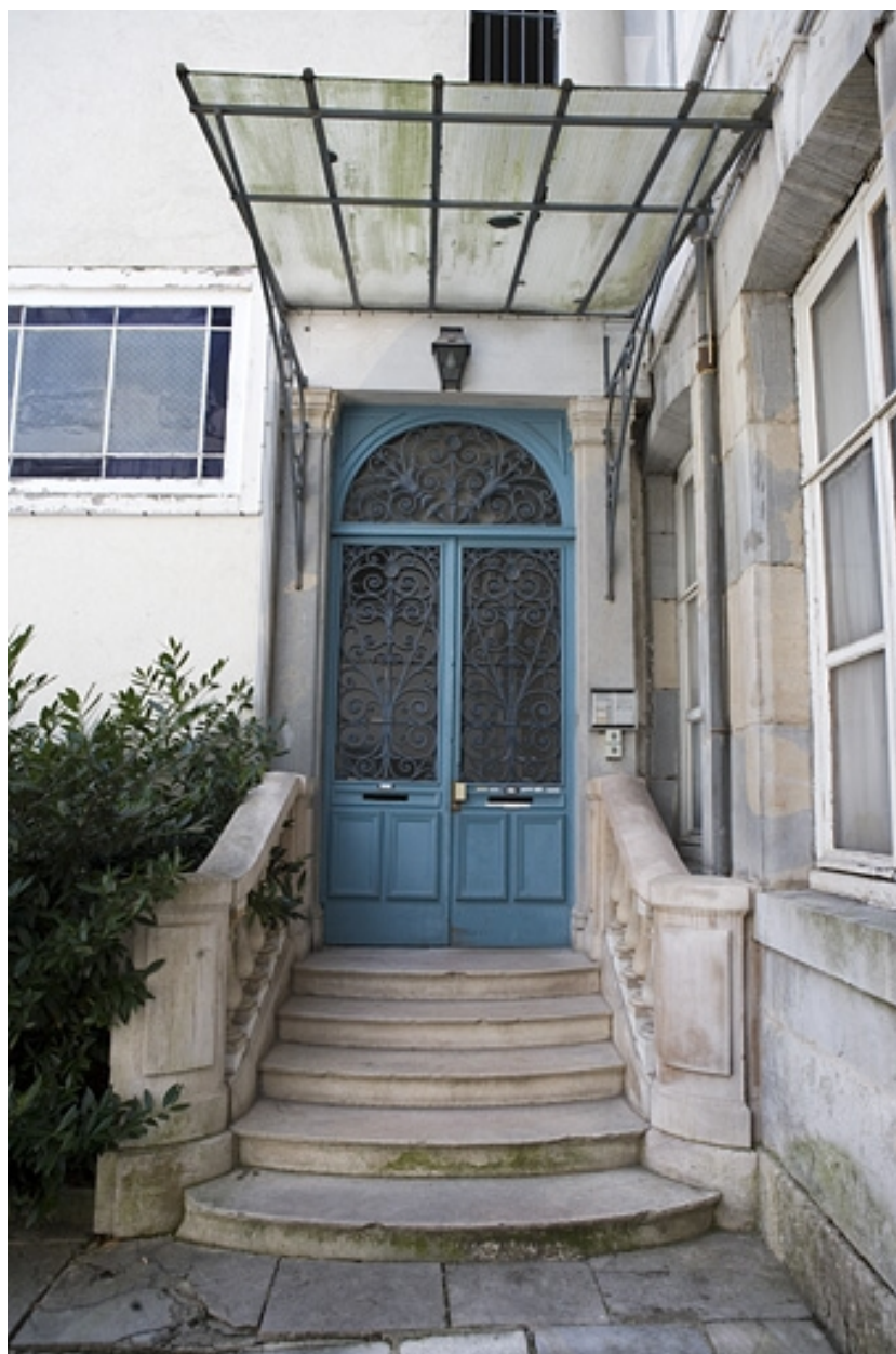
Détail de la porte d'entrée de l'escalier situé dans l'aile droite sur cour.
