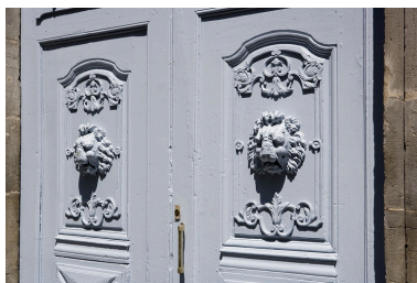
Logis principal : détail des deux vantaux du portail d'entrée décorés d'une tête de lion.
