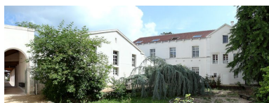
Vue de la deuxième cour. Phot. Alain Morelière IVR26_20118900041NUC2A
