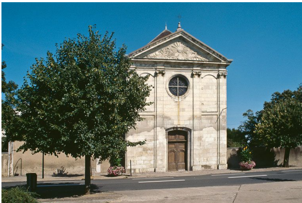
Façade de la chapelle.
