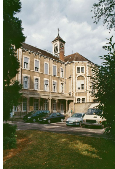
Bâtiment central, façade postérieure avec galerie en 2001. Phot. Jean-Luc Duthu IVR26_20018900120ZA
