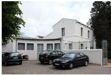
Pavillon du concierge. Phot. Alain Morelière IVR26_20118900016NUC2A
