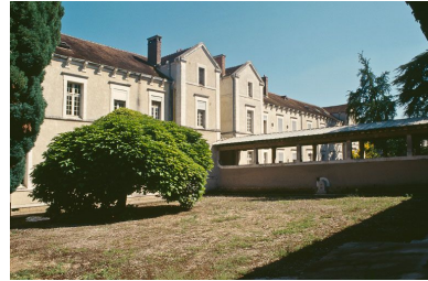
Quartier des femmes, bâtiments postérieurs, façades ouest. Phot. Jean-Luc Duthu IVR26_20018900138ZA
