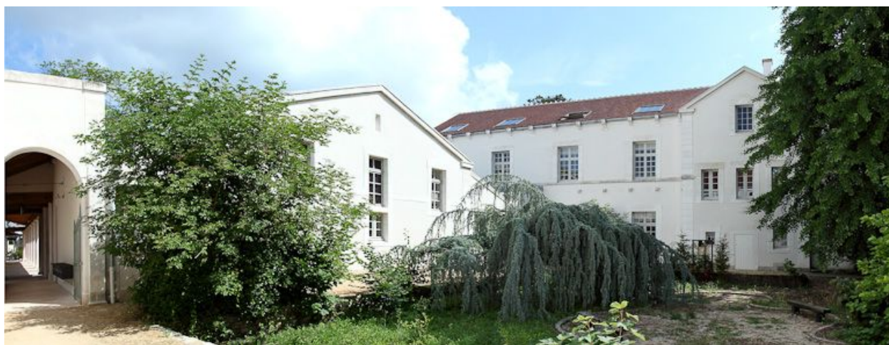
Vue de la deuxième cour.
