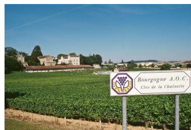
Vue d'ensemble avec les vignes. Phot. Jean-Luc Duthu IVR26_20018900142ZA
