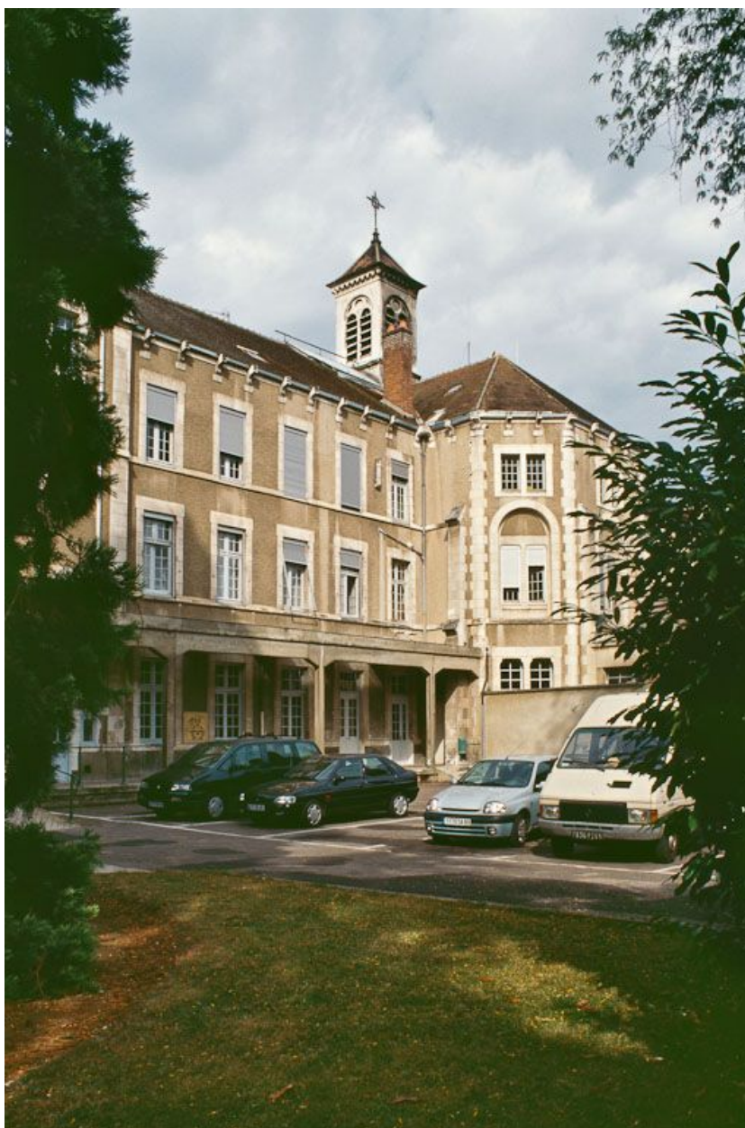
Bâtiment central, façade postérieure avec galerie en 2001.
