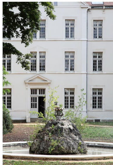
Bassin devant le bâtiment central. Phot. Alain Morelière IVR26_20118900035NUC2A
