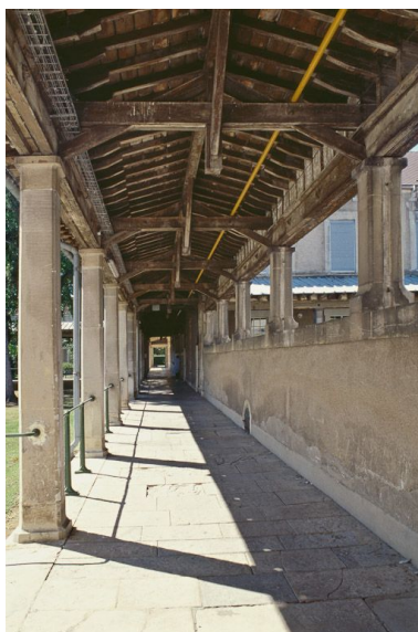
Galerie de liaison, intérieur. Phot. Jean-Luc Duthu IVR26_20018900128ZA
