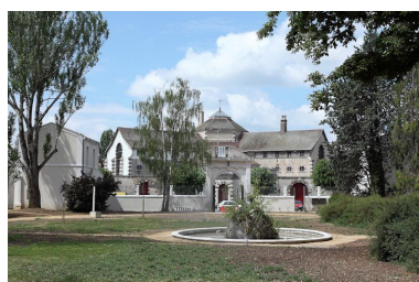
Revers du portail d'entrée et prison. Phot. Alain Morelière IVR26_20118900034NUC2A
