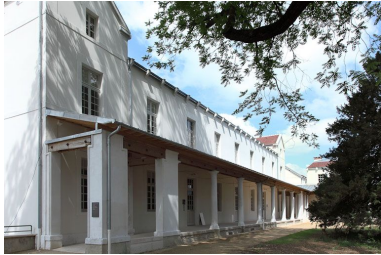
Bâtiment de l'ancien quartier des femmes. Phot. Alain Morelière IVR26_20118900033NUC2A
