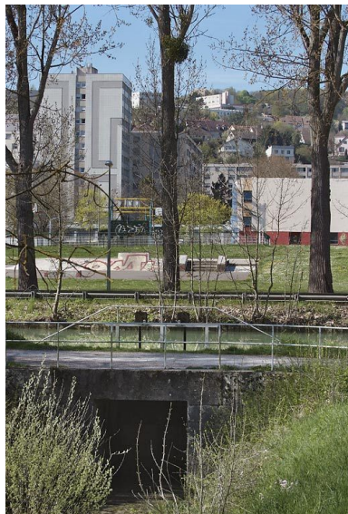
Déversoir. Phot. Thierry Kuntz IVR26_20112102617NUC2A
