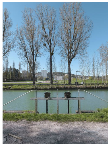
Déversoir du canal dans l'Ouche : vannes. Phot. Thierry Kuntz IVR26_20112102624NUC4A
