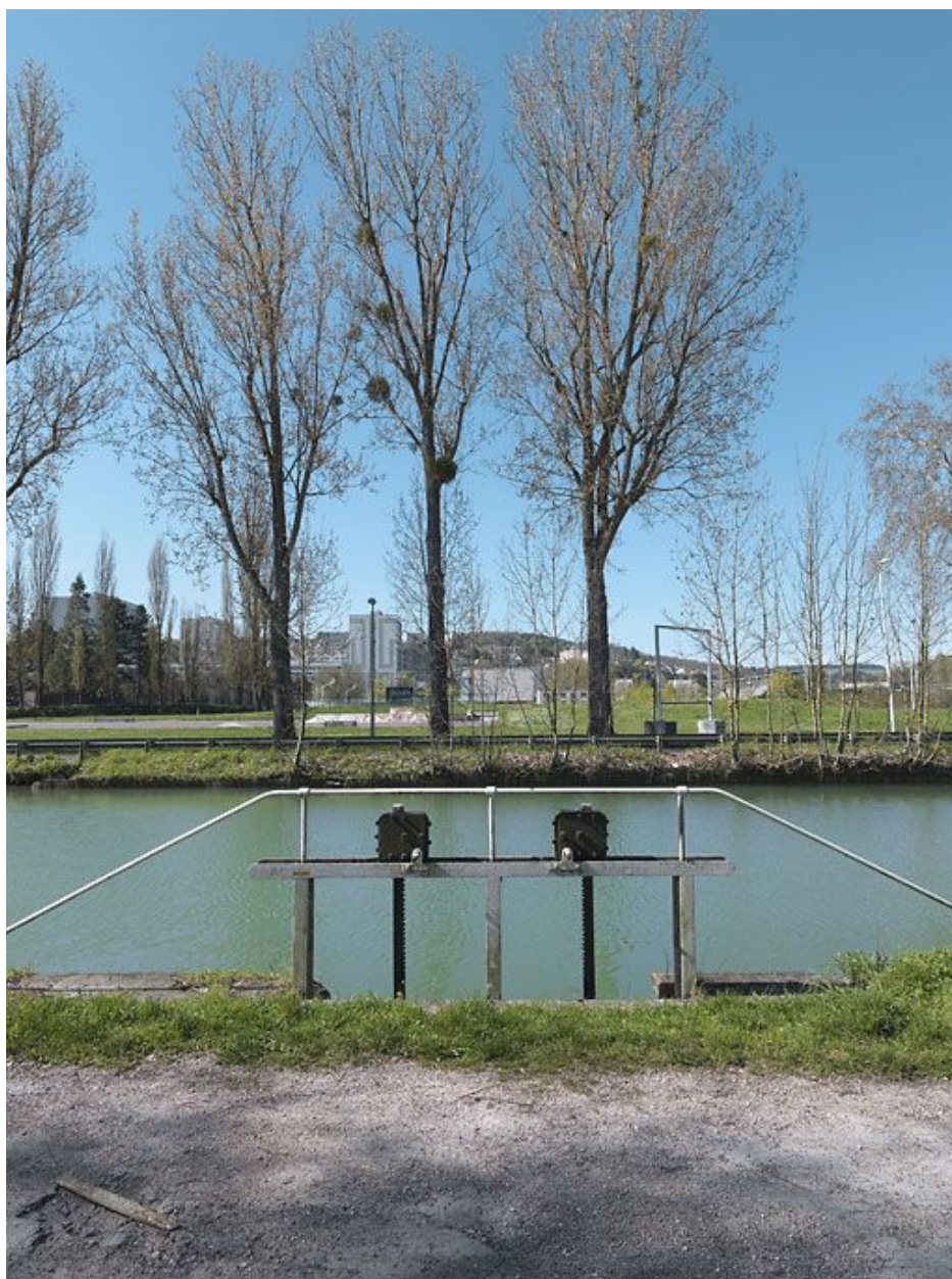
Déversoir du canal dans l'Ouche : vannes.
