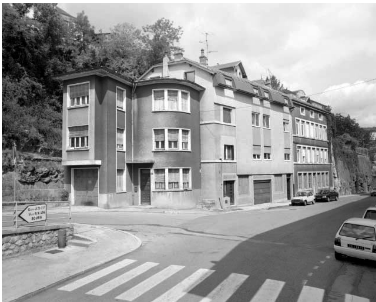
Bâtiments n° 23 et 25 de trois quarts gauche.
