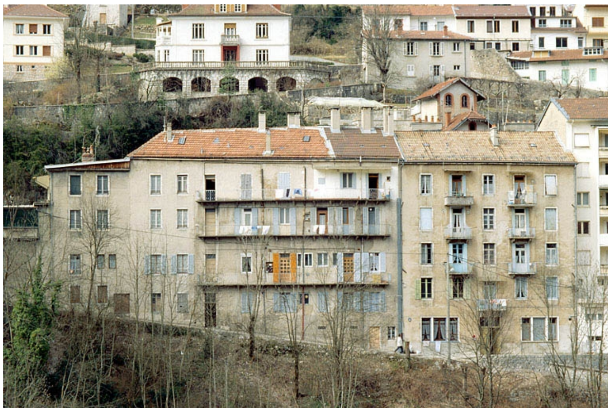
Façade postérieure des immeubles n° 22 et 24.
