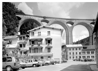
Elévation latérale gauche. Phot. Yves Sancey IVR43_20033900079V
