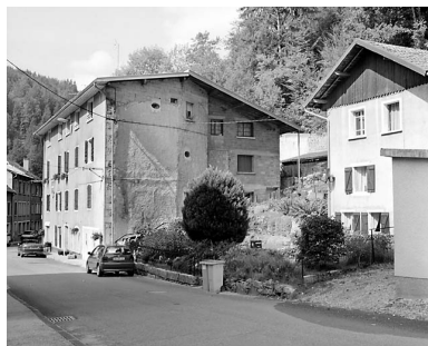
Elévation latérale droite. Phot. Yves Sancey IVR43_20033900080X
