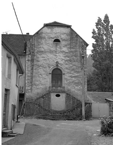
Chapelle : façade antérieure. Phot. Yves Sancey IVR43_19843900225X
