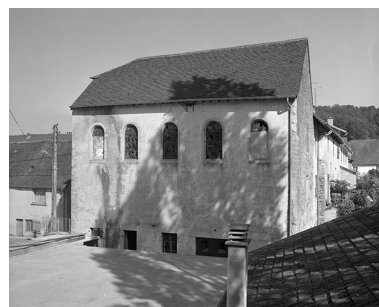
Chapelle : façade latérale droite. Phot. Yves Sancey IVR43_19843900226X
