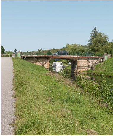
Vue du pont.
