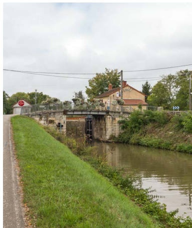
Vue d'ensemble du pont.
