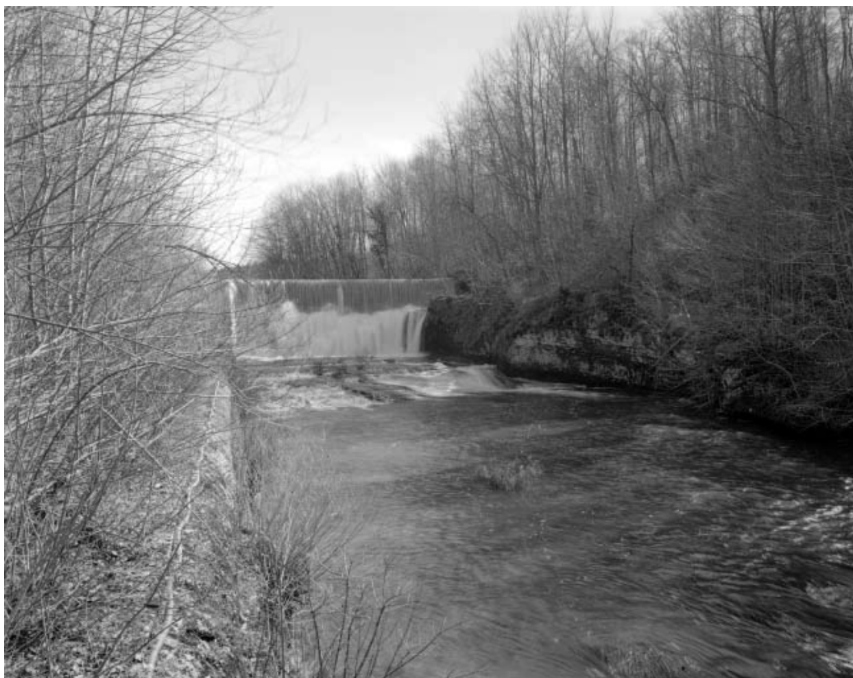
Barrage à crête déversante sur l'Angillon.
