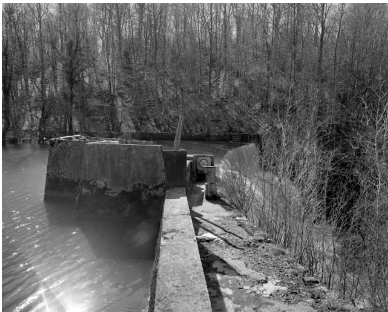
Tour de prise d'eau et barrage.
