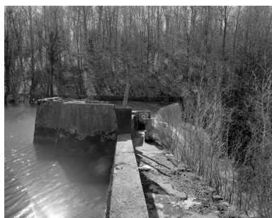
Tour de prise d'eau et barrage.
