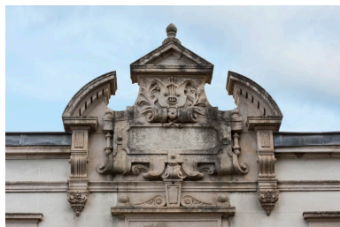
Façade antérieure : fronton échancré sculpté. Phot. Pierre-Marie Barbe-Richaud IVR26_20212100239NUC4A
