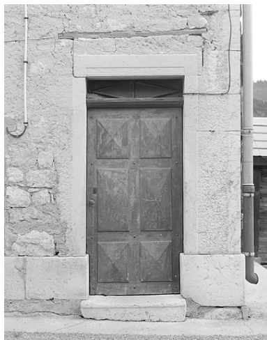
Porte d'accès. Phot. Jérôme Mongreville IVR43_19963901527X
