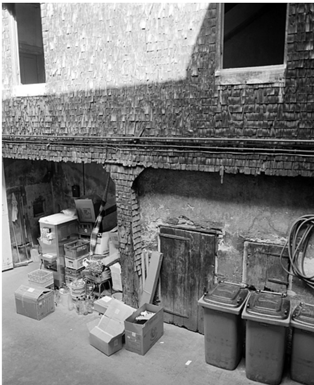
Escalier dans la cour, partie inférieure.
