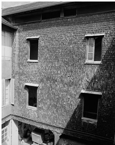
Escalier dans la cour à cage fermée. Phot. Yves Sancey IVR43_19833900180X
