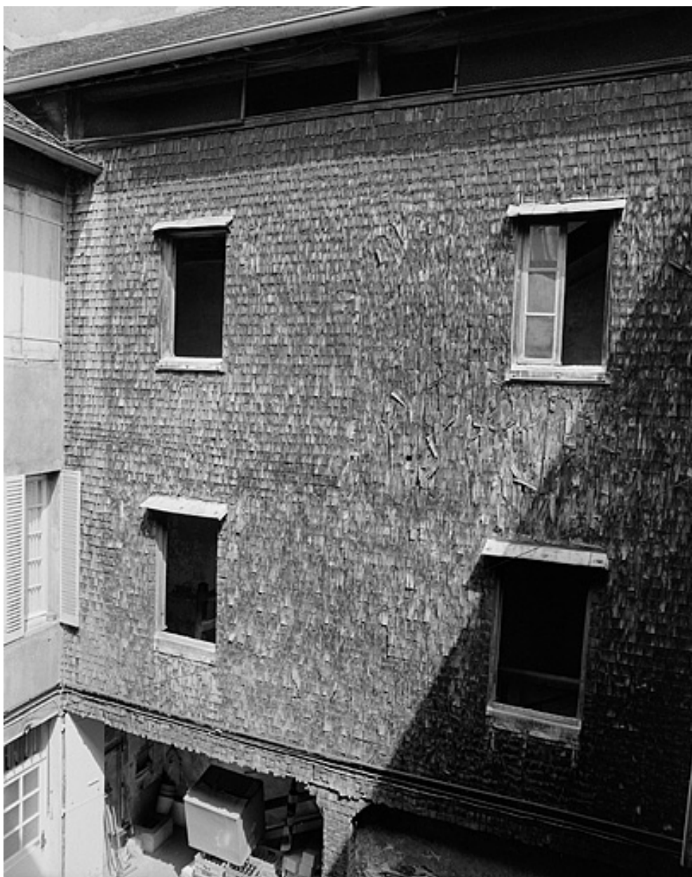
Escalier dans la cour à cage fermée.
