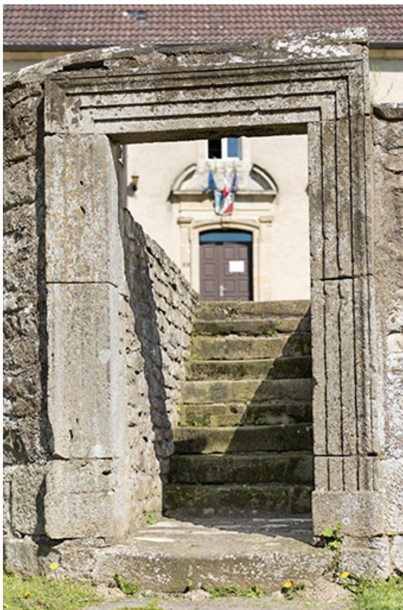
Porte extérieure située dans le mur d'enclos.
