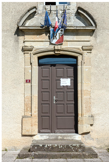
Porte de la façade principale. Phot. Sonia Dourlot IVR43_20167000557NUC4A
