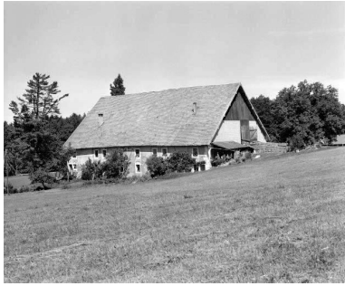
Façades antérieure et latérale droite.
