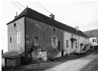
Bâtiment à gauche de la cour. Phot. Michel Rosso IVR26_19867100067V
