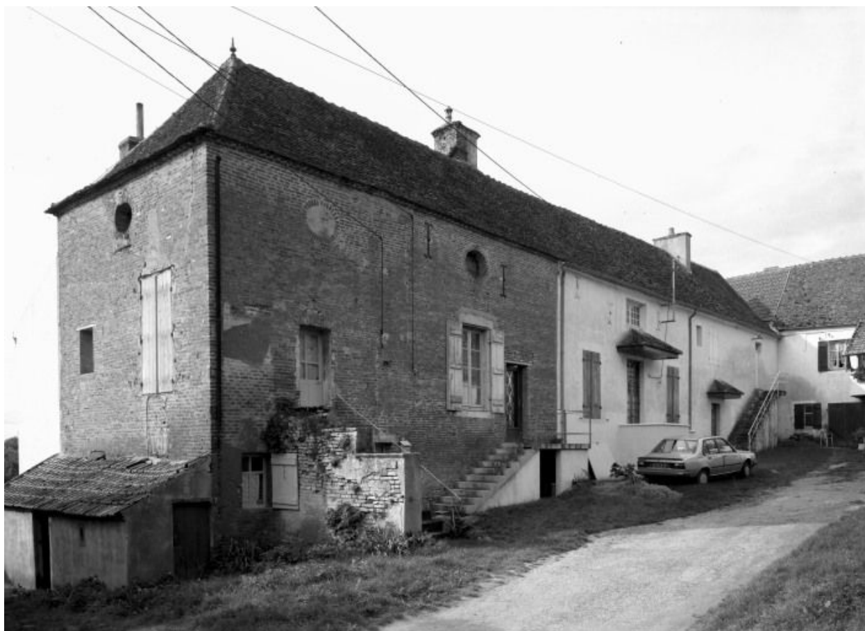
Bâtiment à gauche de la cour.
