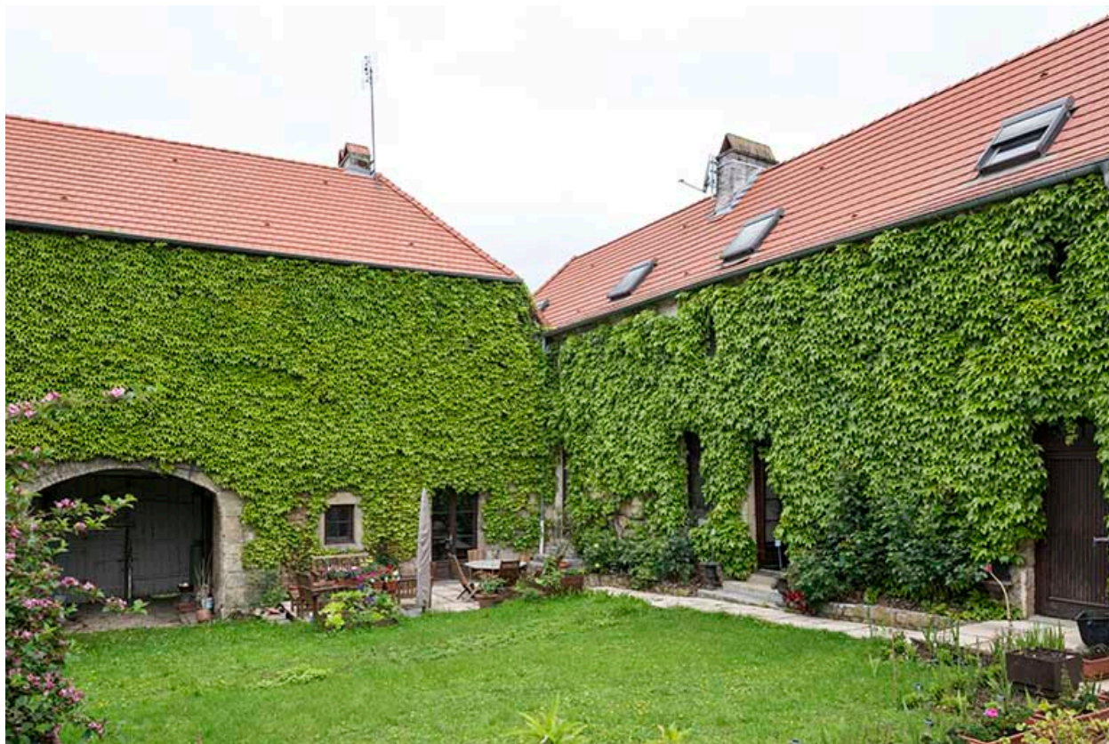
Les façades postérieures.
