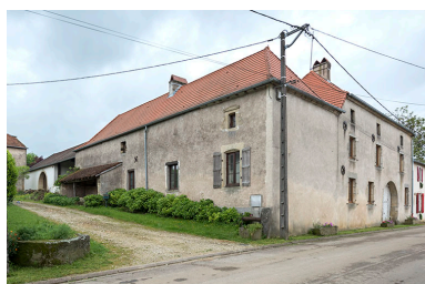
Vue d'ensemble. Phot. Sonia Dourlot IVR43_20167000640NUC4A
