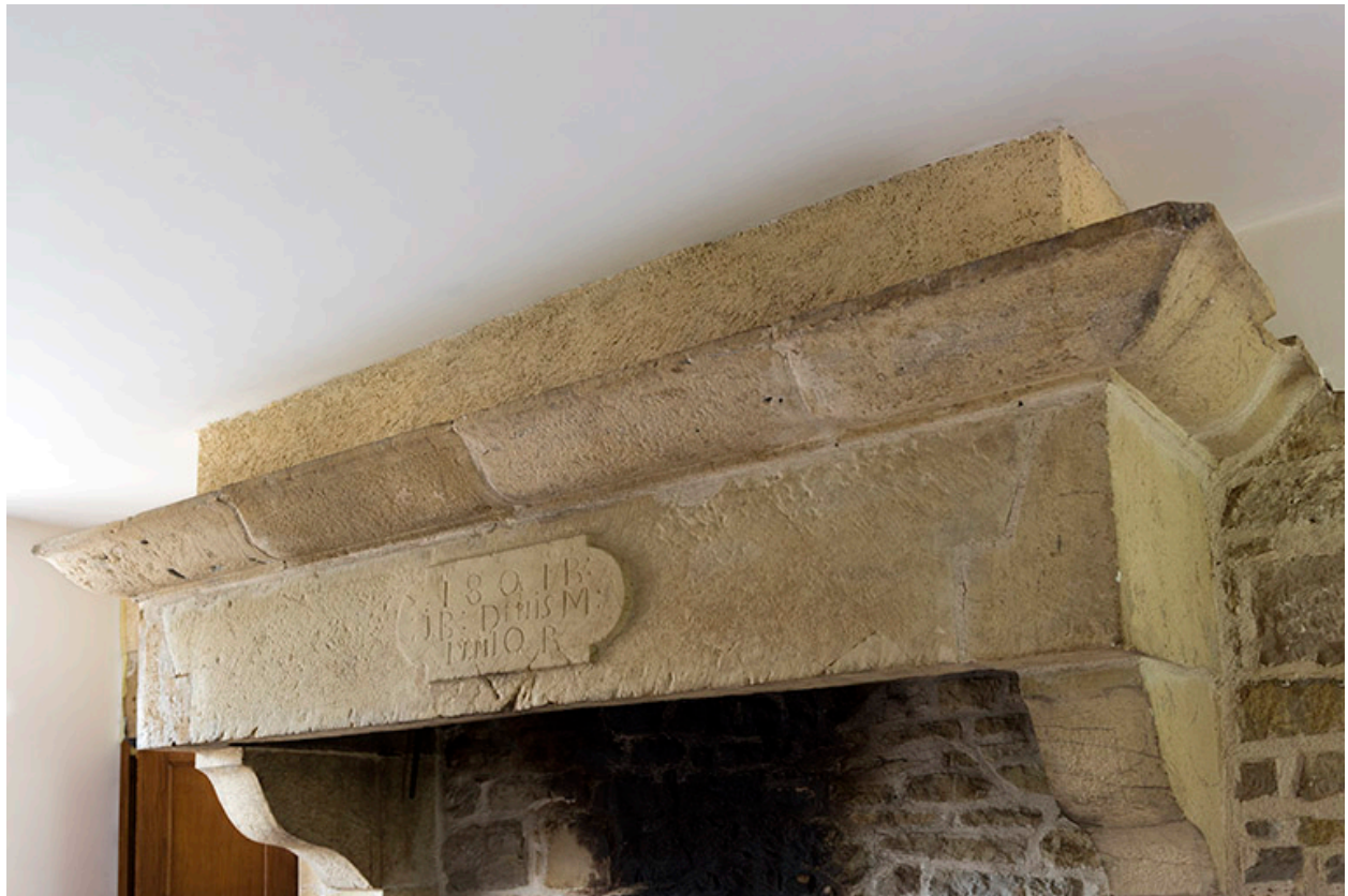
Cheminée dans la ferme côté rue.
