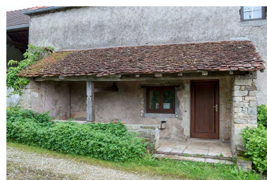
Auvent protégeant l'entrée. Phot. Sonia Dourlot IVR43_20167000641NUC4A
