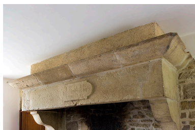
Cheminée dans la ferme côté rue. Phot. Sonia Dourlot IVR43_20167000642NUC4A
