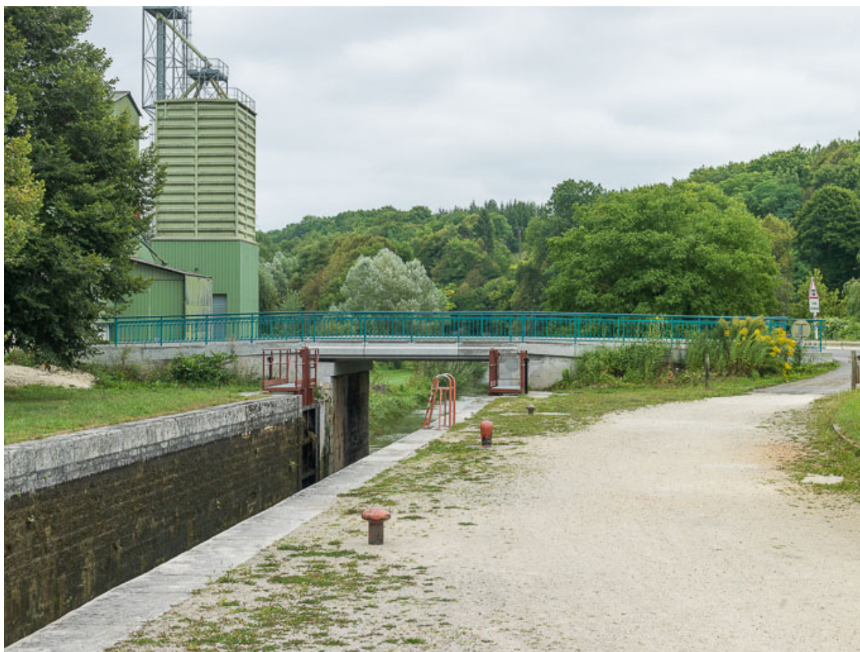
Vue d'ensemble du pont.
