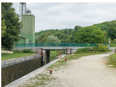
Vue d'ensemble du pont.
