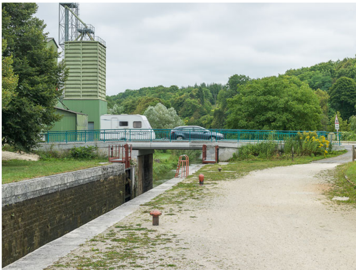
Vue du site.
