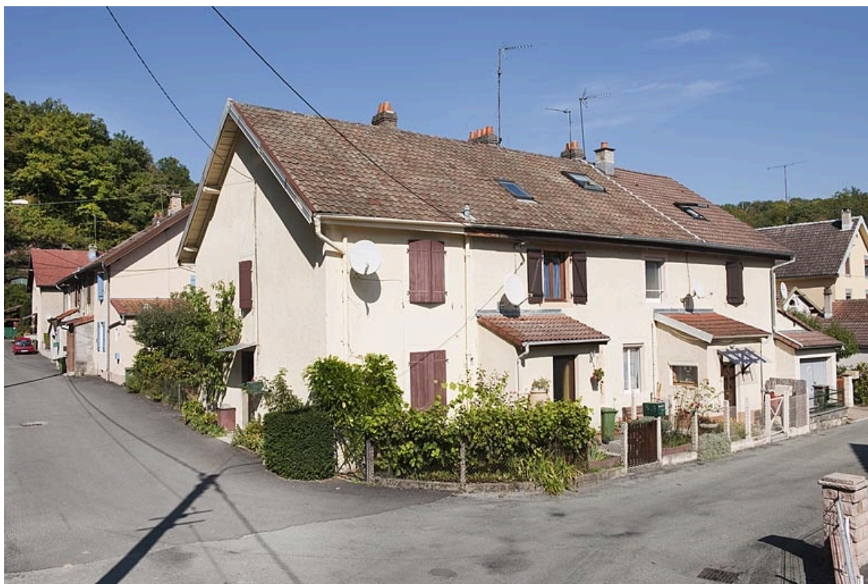
Habitation à quatre logements rue des Essarts.
