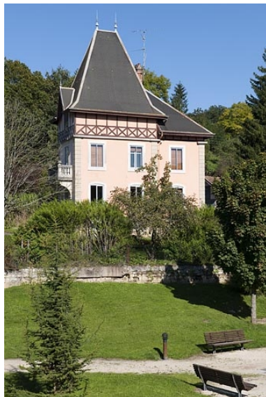
Logement patronal Henri Mégnin. Façade sud. Phot. Jérôme Mongreville IVR43_20122501840NUC4A
