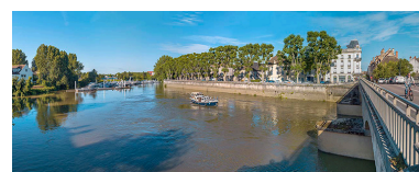
Vue des remparts depuis le pont, rue de Strasbourg. Phot. Thierry Kuntz IVR26_20247100100NUC4A
