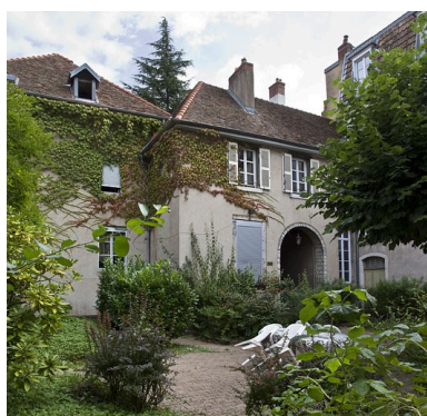
Deuxième logis secondaire, façade postérieure depuis le fond du jardin : de trois quarts gauche. Phot. Yves Sancey IVR43_20112502855NUC2A
