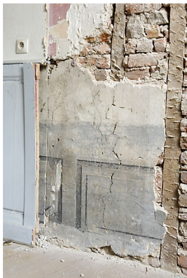
Détail d'une peinture murale sous un lambris d'appui dans une pièce du premier étage : vue rapprochée. Phot. Jérôme Mongreville IVR43_20072500405NUCA
