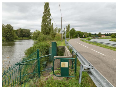
Vue de l'aqueduc.
