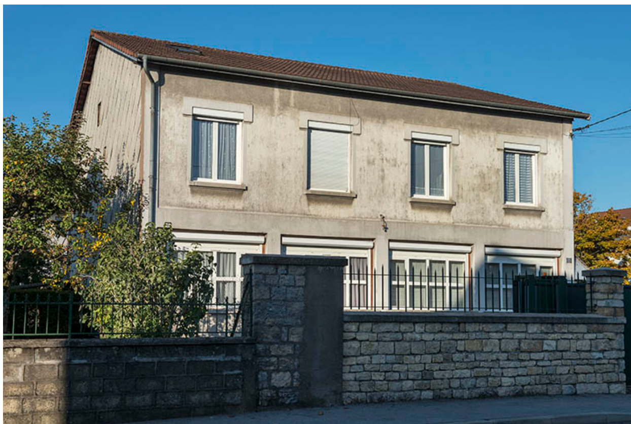
Façade est de l'atelier.
