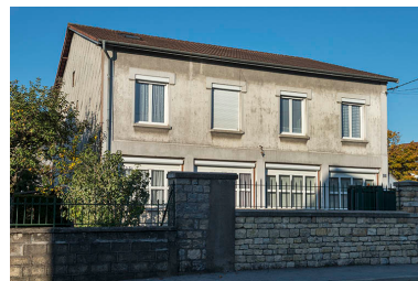
Façade est de l'atelier. Phot. Jérôme Mongreville IVR43_20172501312NUC4A
