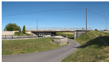
Pont sur écluse avec sas au premier plan. Phot. Thierry Kuntz IVR26_20112103024NUC4A
