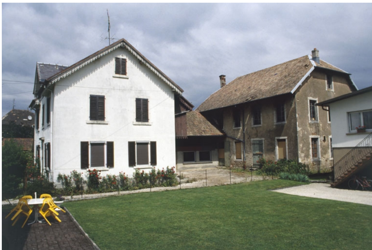
Vue d'ensemble depuis l'ouest.
