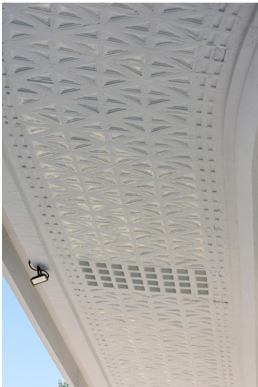
Face inférieure de l'auvent en béton armé.
