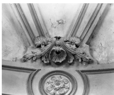
Chœur, détail de la voûte Phot. Michel Thierry IVR26_19852101426X
