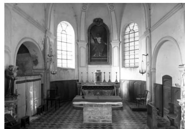
Vue intérieure du chœur Phot. Jean-Luc Duthu IVR26_19852101421V
