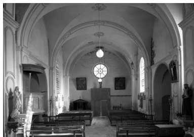
Vue intérieure prise du chœur Phot. Jean-Luc Duthu IVR26_19852101422V
