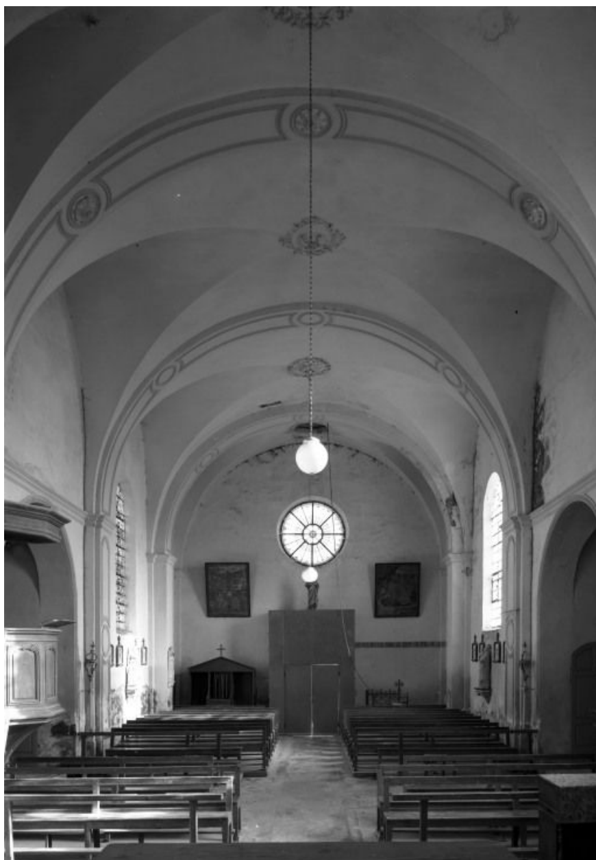
Vue intérieure prise du chœur
