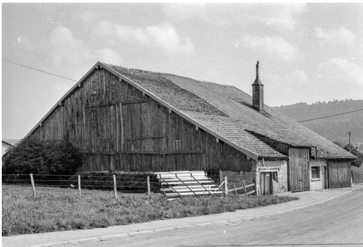
Ferme cadastrée 1973 ZE 31a : façade postérieure.
