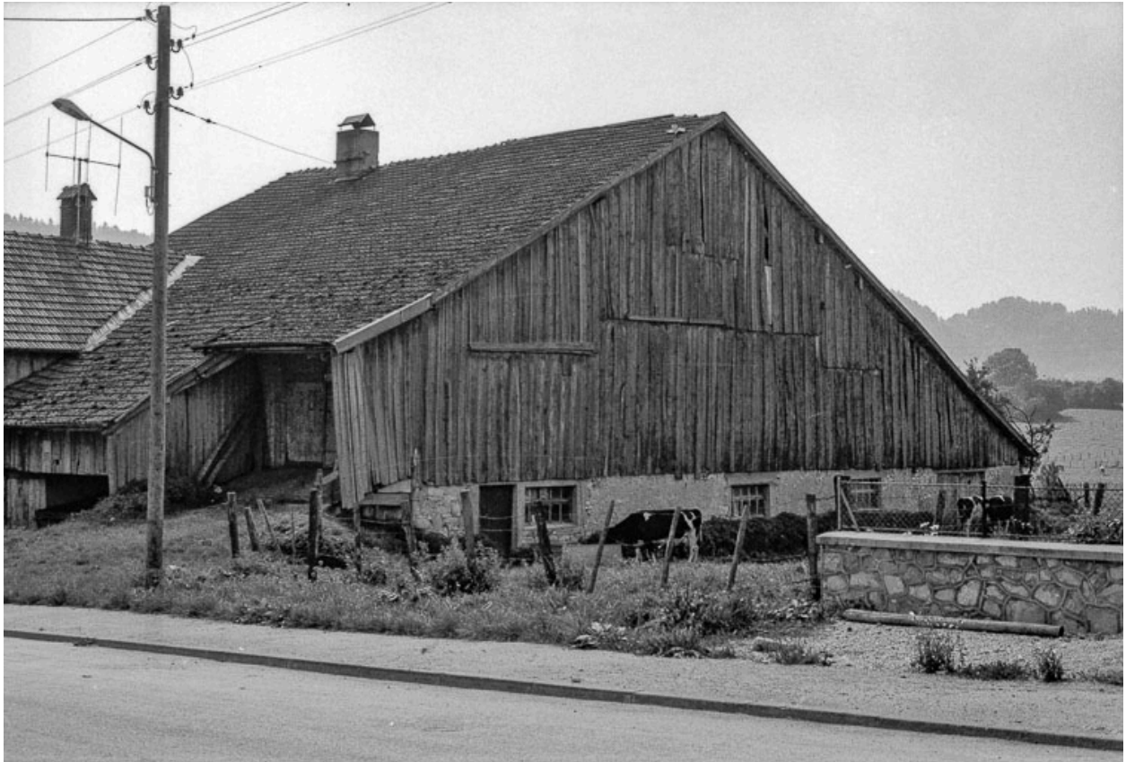
Ferme : façade latérale droite.
