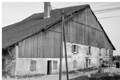
Ferme cadastrée 1964 D 131-133 : façade antérieure. Phot. Gilbert Poinot IVR43_19752501450Z
