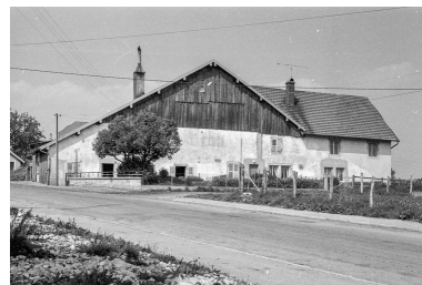
Ferme cadastrée 1973 ZE 31a : façade antérieure. Phot. Gilbert Poinot IVR43_19752501297Z
