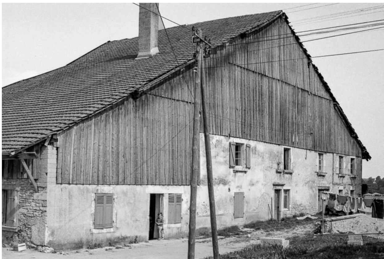
Ferme cadastrée 1964 D 131-133 : façade antérieure.
