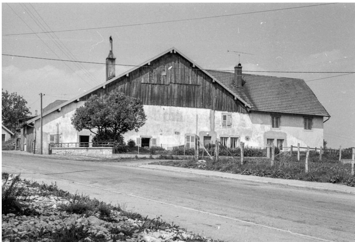
Ferme cadastrée 1973 ZE 31a : façade antérieure.
