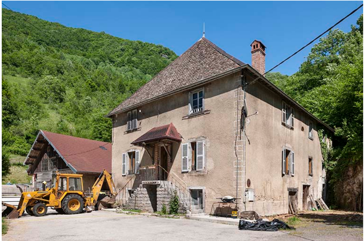
Atelier de scierie et logement patronal.
