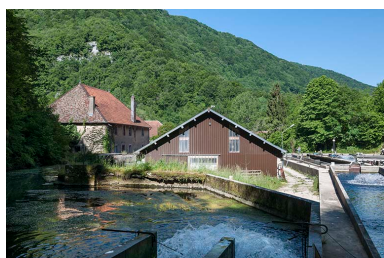
Vue depuis l'emplacement du bassin de retenue. Phot. Jérôme Mongreville IVR43_20152501262NUC4A
