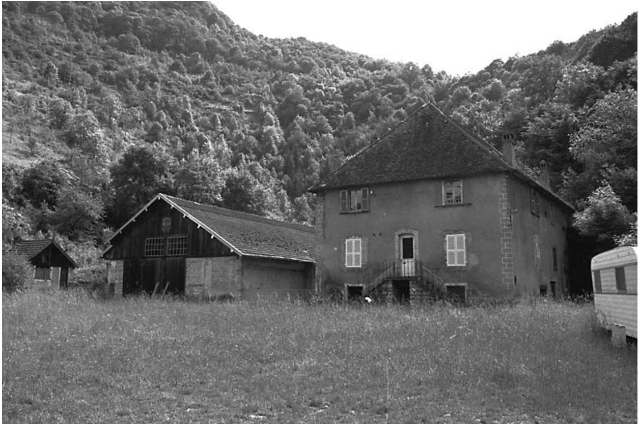
L'atelier de scierie et le logement patronal en 1980.
