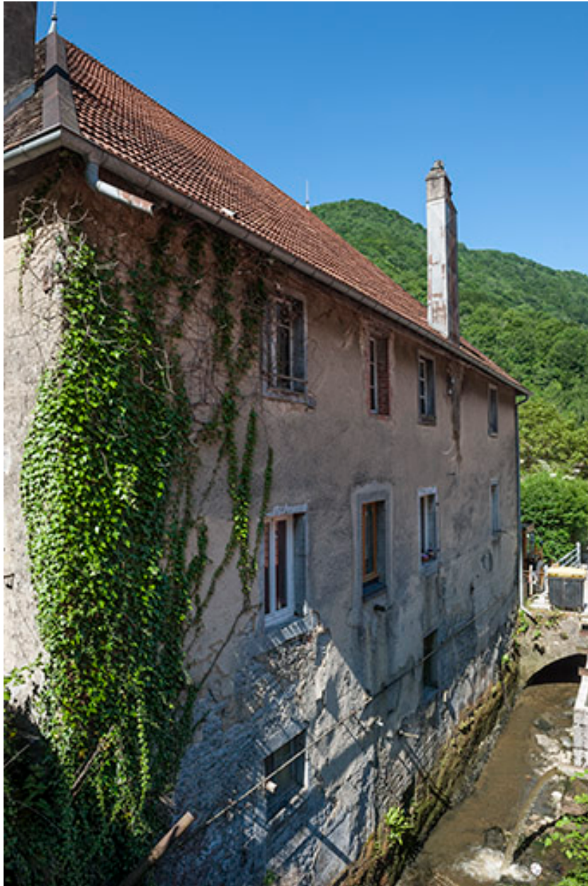
Façade nord du logement (ancien atelier).
