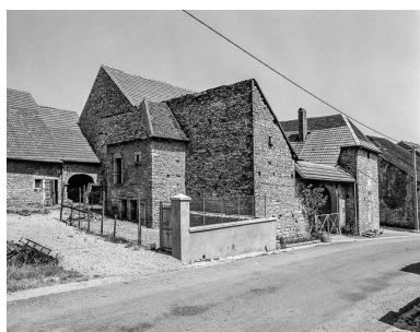
Pigeonnier situé en face de l'habitation. Phot. Dominique Humbert IVR43_19767000496X
