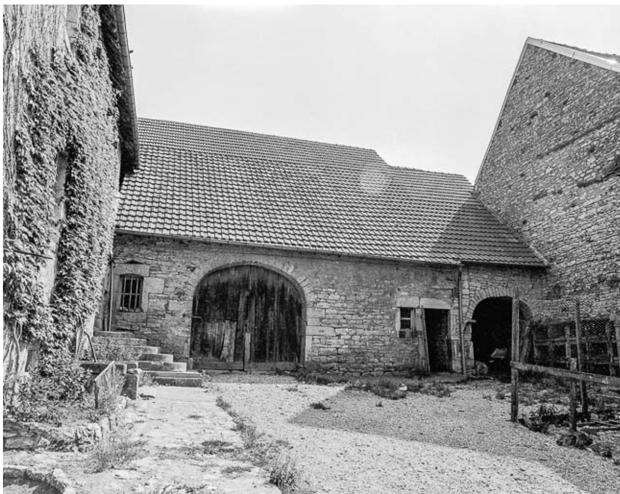
Dépendances et escaliers menant à l'habitation.
