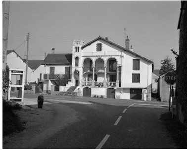
Façade antérieure vue de face. Phot. Yves Sancey IVR43_19843900201X
