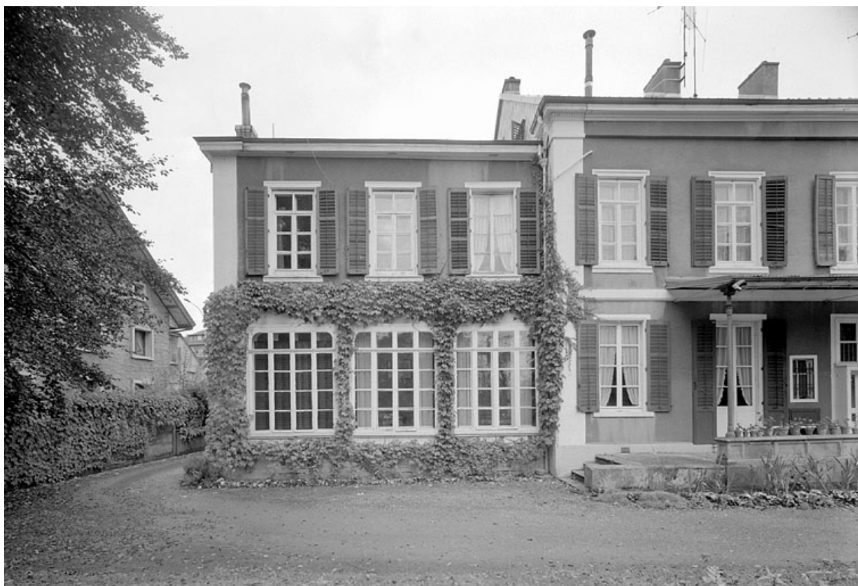
Façade sur jardin. Aile ouest.
