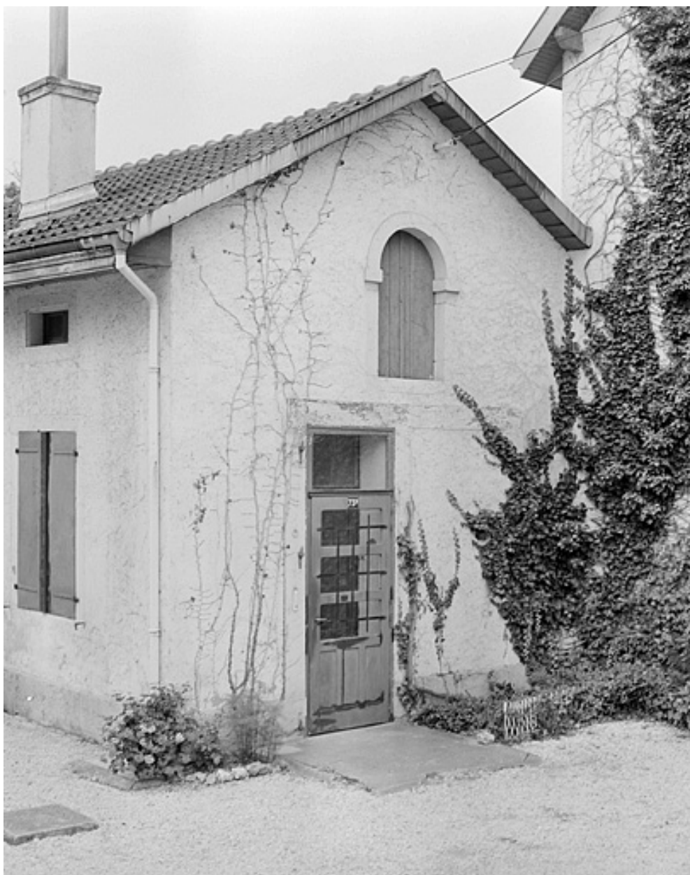
Anciennes écuries. Façade nord.
