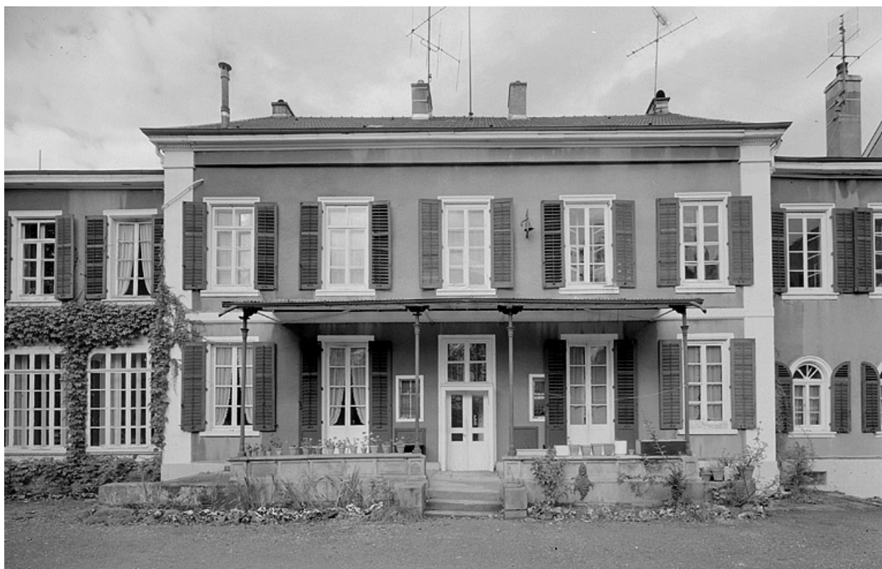
Façade sur jardin. Partie centrale.
