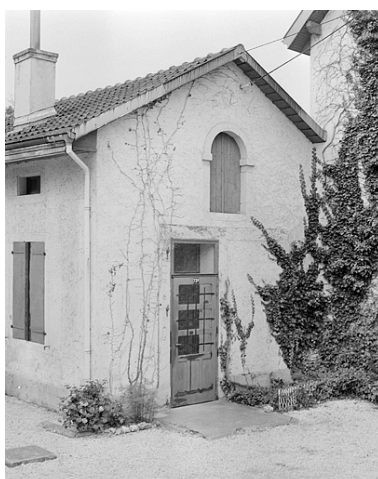
Anciennes écuries. Façade nord. Phot. Jérôme Mongreville IVR43_19872500517X
