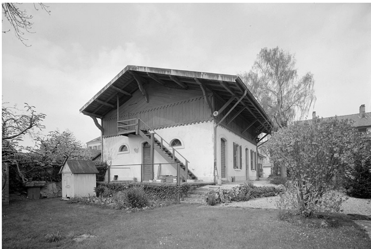
Remise à voitures. Façades sud et est.
