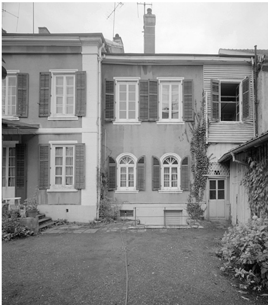
Façade sur jardin. Aile est.
