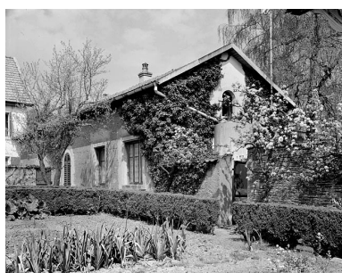
Anciennes écuries. Façades sud et ouest. Phot. Jérôme Mongreville IVR43_19882500086V
