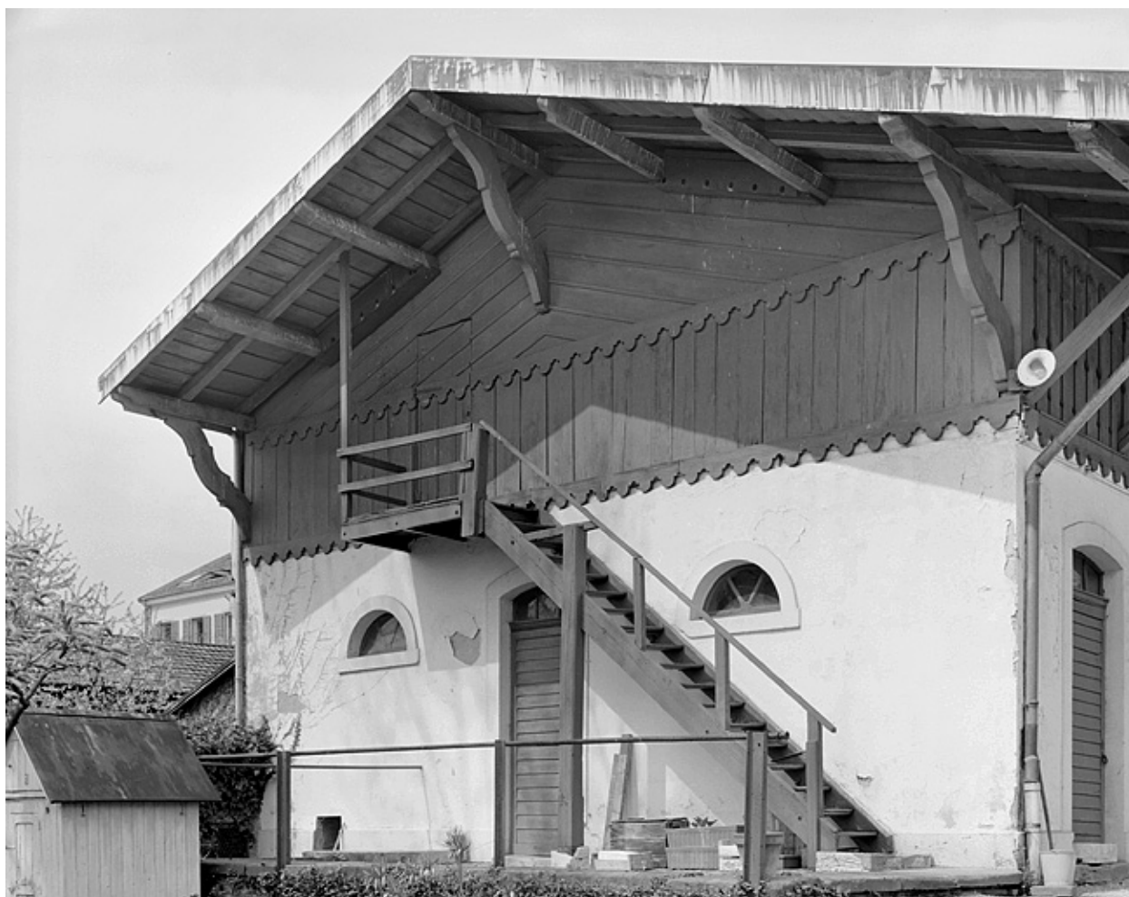
Remise à voitures. Façade sud.
