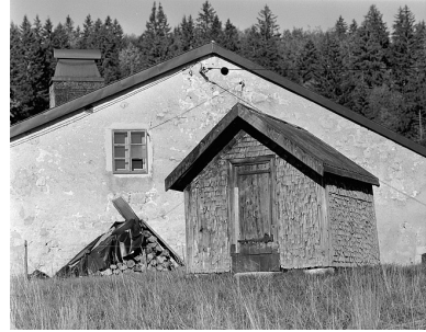
Le grenier fort. Phot. Jérôme Mongreville IVR43_19963901476X
