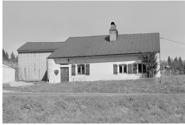
Façade antérieure. Phot. Jérôme Mongreville IVR43_19963901479X
