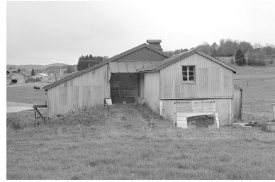
Face sud-ouest. Phot. Jérôme Mongreville IVR43_19963901477X
