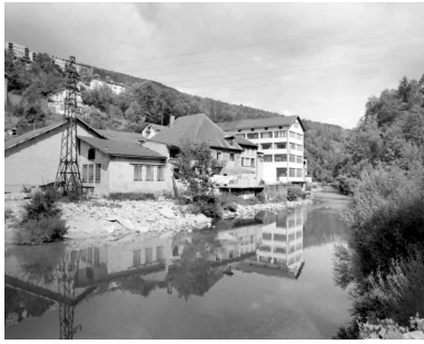
Façade postérieure des bâtiments, depuis l'aval. Phot. Jérôme Mongreville IVR43_19923900659X
