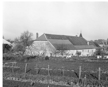
Façade postérieure : vue éloignée Phot. Yves Sancey IVR43_19847000043X
