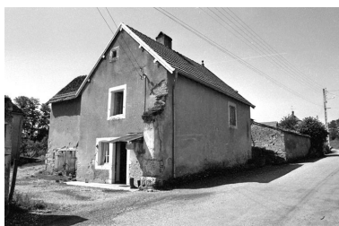
Logement indépendant à l'entrée de la cour. Phot. Bernard Lardière IVR43_19817000640Z
