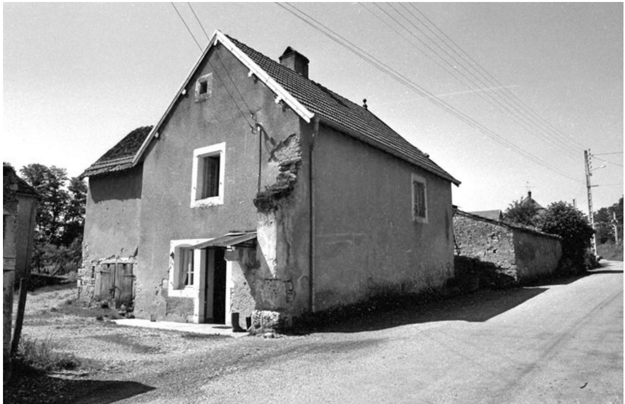
Logement indépendant à l'entrée de la cour.
