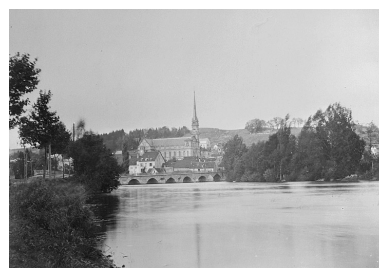
Grand Pont et Neuve Ville, début 20e siècle. Phot. IVR43_19862500471V
