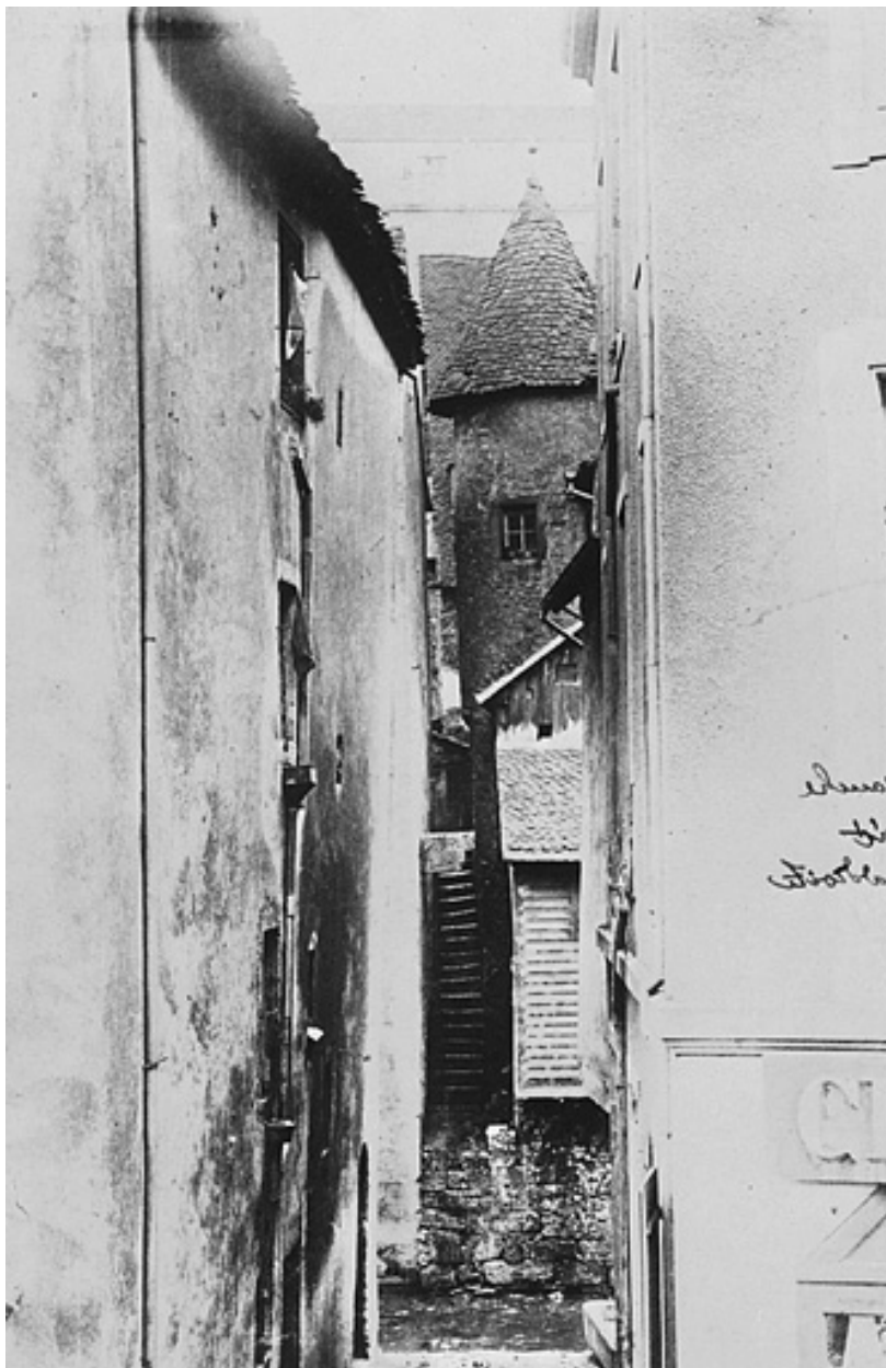
Ruelle des Etaux, fin 19e siècle.
