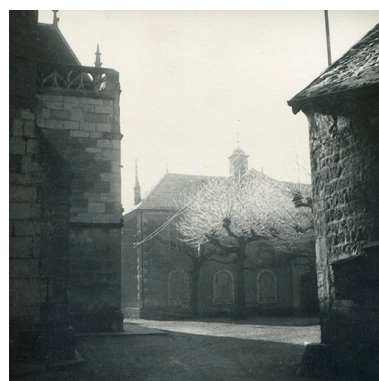
Place Saint-Anatoile et école Saint-Charles, depuis le nord, s.d. [vers 1950]. Phot. Georges Chenu IVR43_20243900153NUC4A
