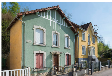
Implantation de la maison par rapport au "pavillon vert". Phot. Jérôme Mongreville IVR43_20177000506NUC4A
