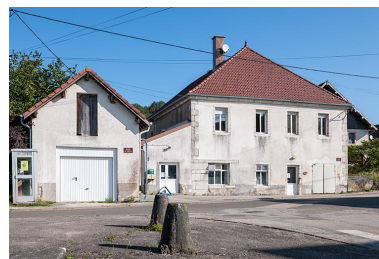
Façade antérieure depuis le sud. Phot. Jérôme Mongreville IVR43_20142501143NUC4A
