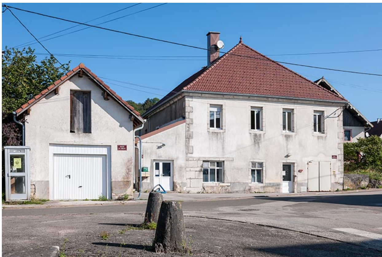
Façade antérieure depuis le sud.
