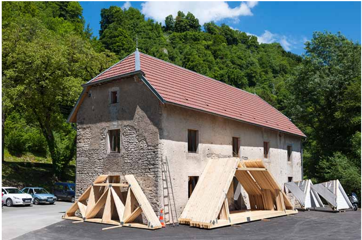
Bâtiment agricole depuis le sud-ouest.
