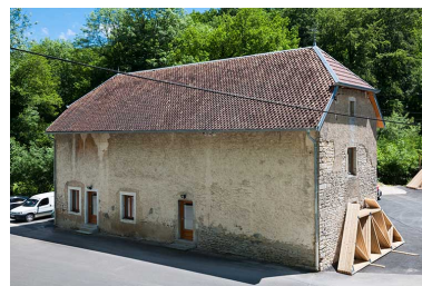
Bâtiment agricole vu de trois quarts. Phot. Jérôme Mongreville IVR43_20132500665NUC4A
