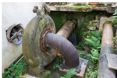
Turbine Goulut-Borne. Phot. Jérôme Mongreville IVR43_20132500664NUC4A
