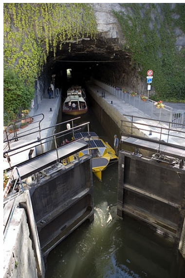
Eclusage : ouverture de la porte aval. Phot. Yves Sancey IVR43_20062500213NUCA
