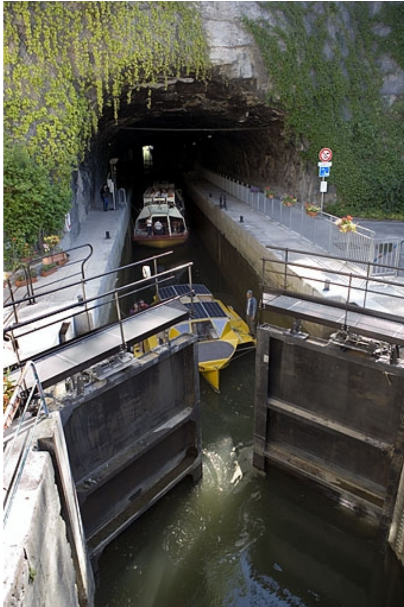
Eclusage : ouverture de la porte aval.
