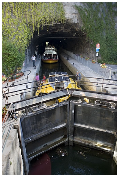
Eclusage : arrivée des bateaux. Phot. Yves Sancey IVR43_20062500212NUCA
