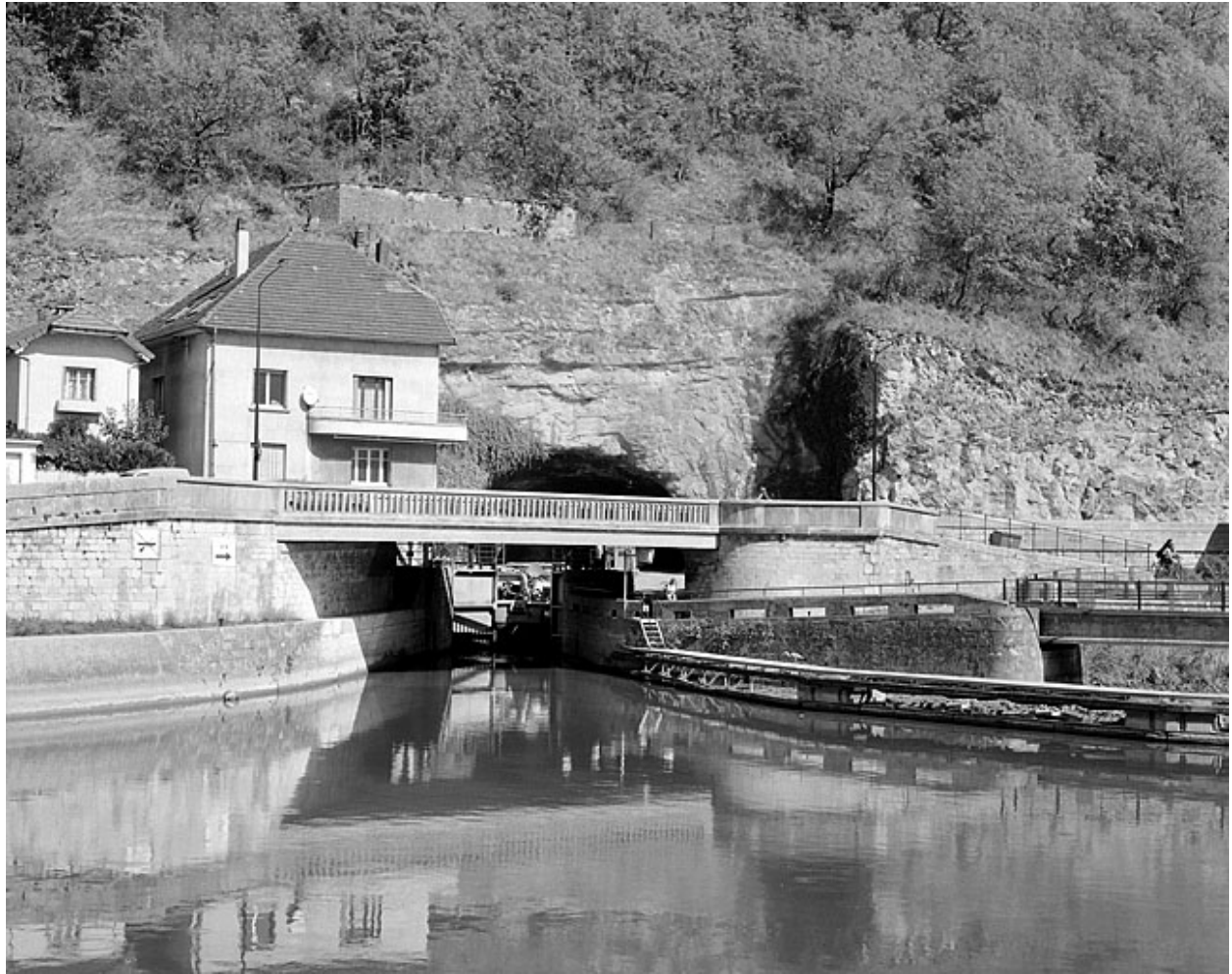
Pont routier, maison d'éclusier, écluse et tunnel.
