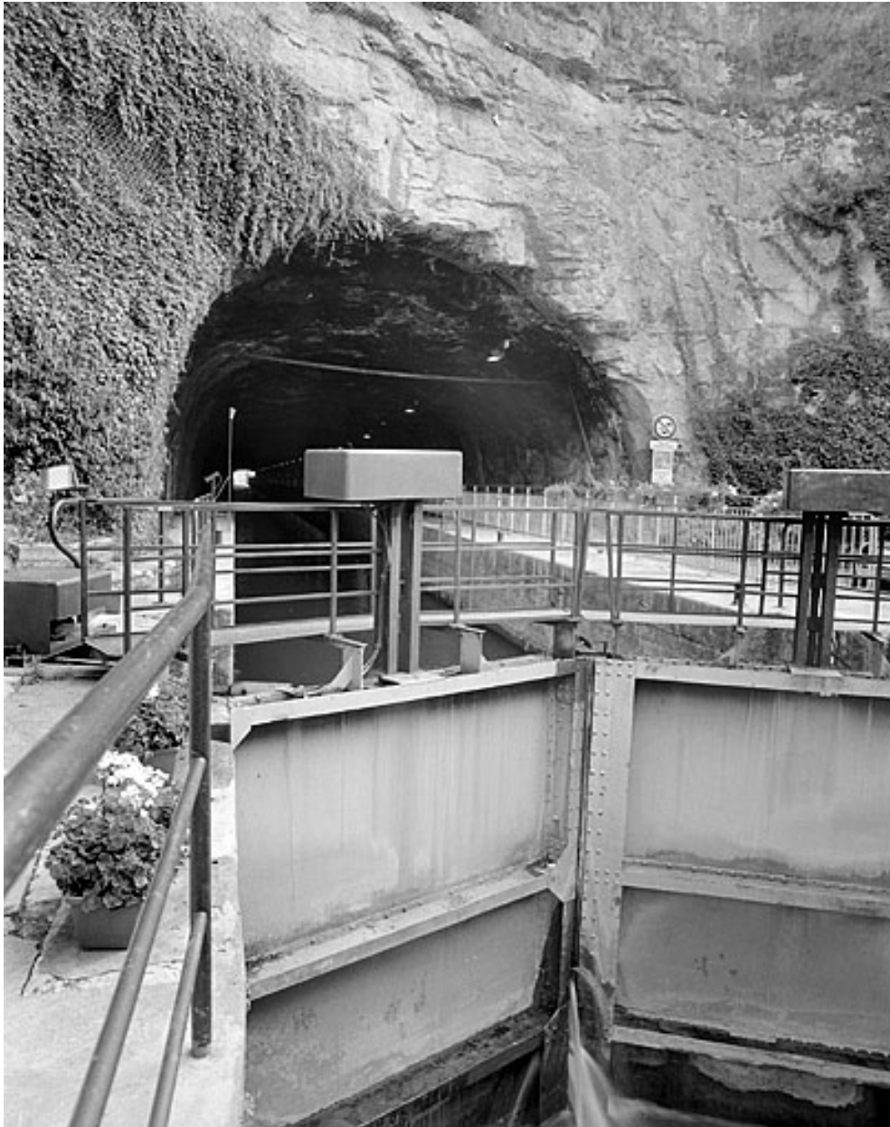
Porte aval de l'écluse et tunnel.
