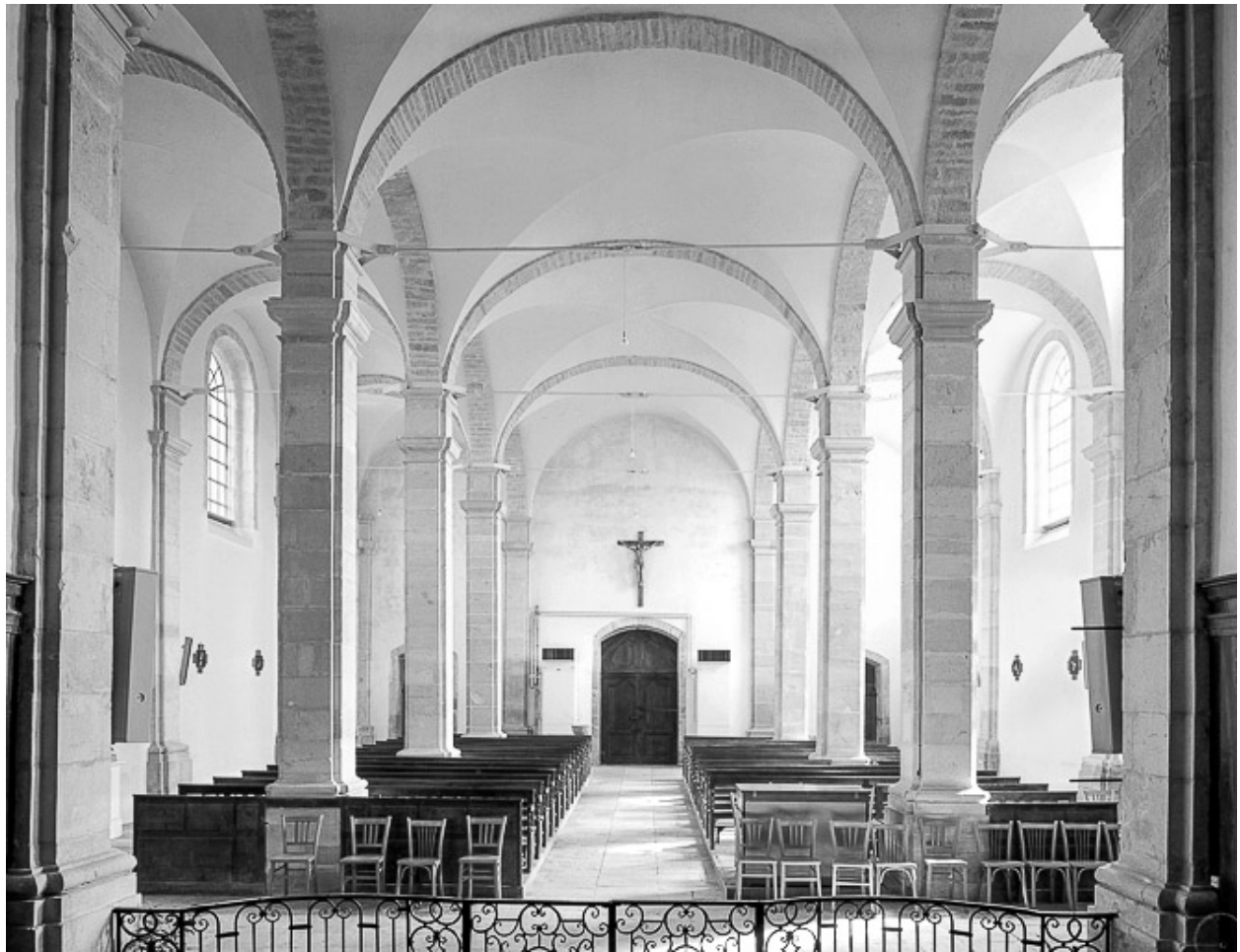
Nef vue depuis le chœur.
