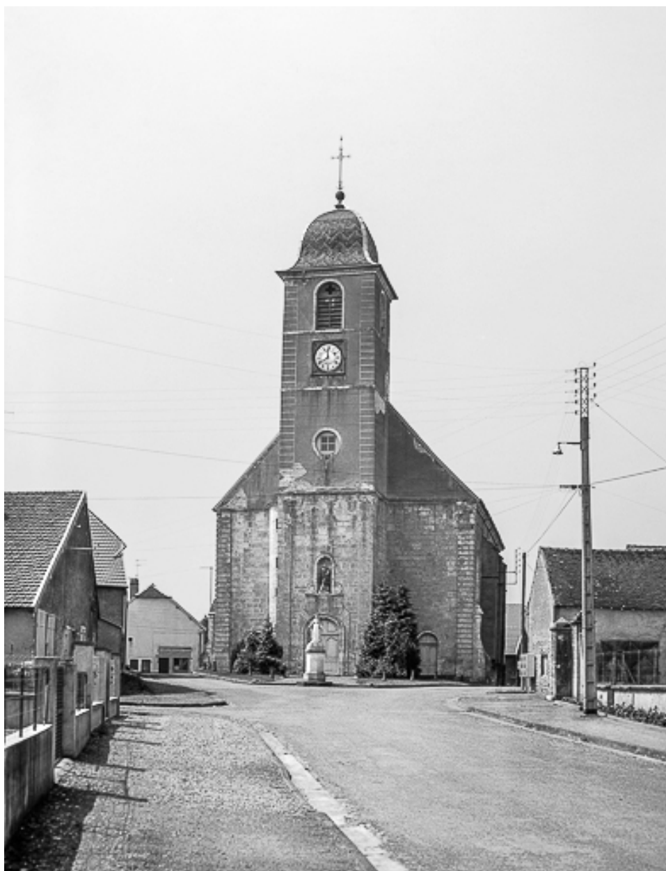
Façade antérieure avec tour-clocher.
